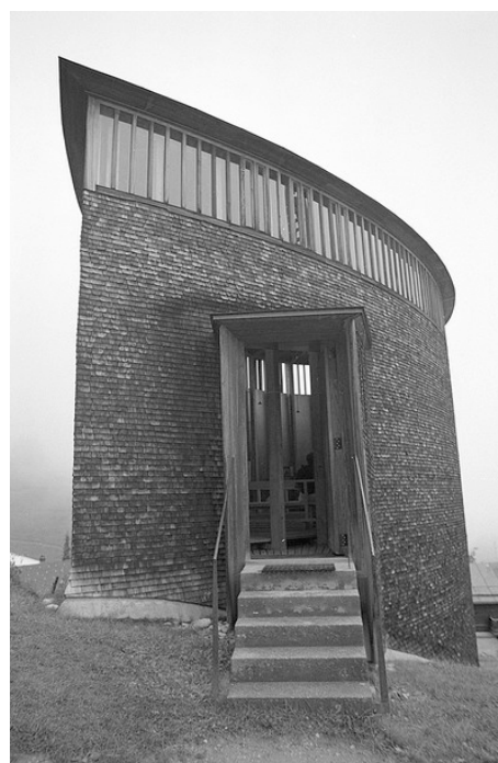
[F.16] Volumen de acceso a la capilla.
