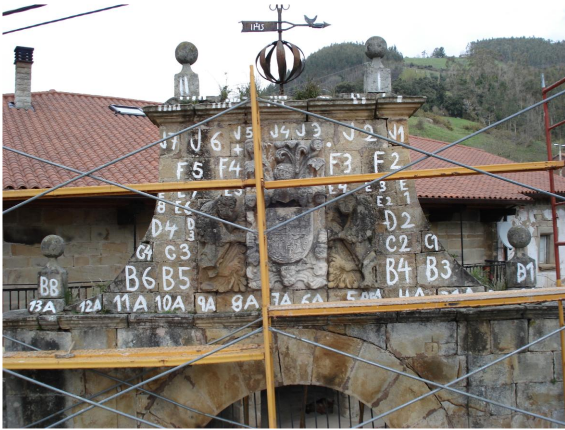
82-(Arriba) y 83(Abajo) proceso de restauración de una portalada: se enumeran las piedras, se desmontan, se sanea todo y se reconstruye de nuevo. Vejeorís.
