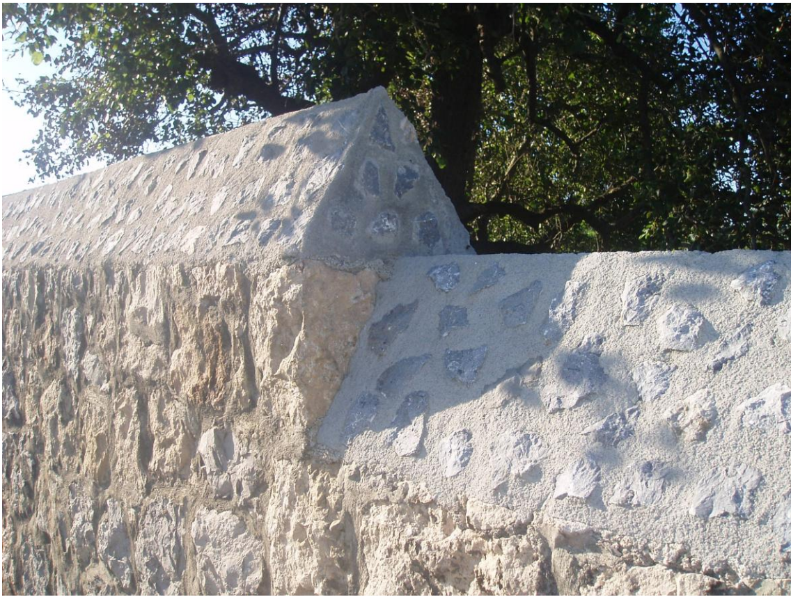
27-(Arriba) Caballete a dos aguas. Los Corrales de Buelna. 28-(Abajo) Idem. Arnuelo.
