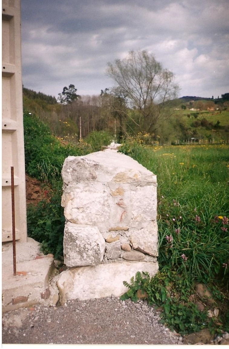
29-Caballete de plano inclinado, aparte de verterse el agua de la lluvia hacia un sólo lado, sirve como símbolo de propiedad. Penilla de Toranzo (1998).
