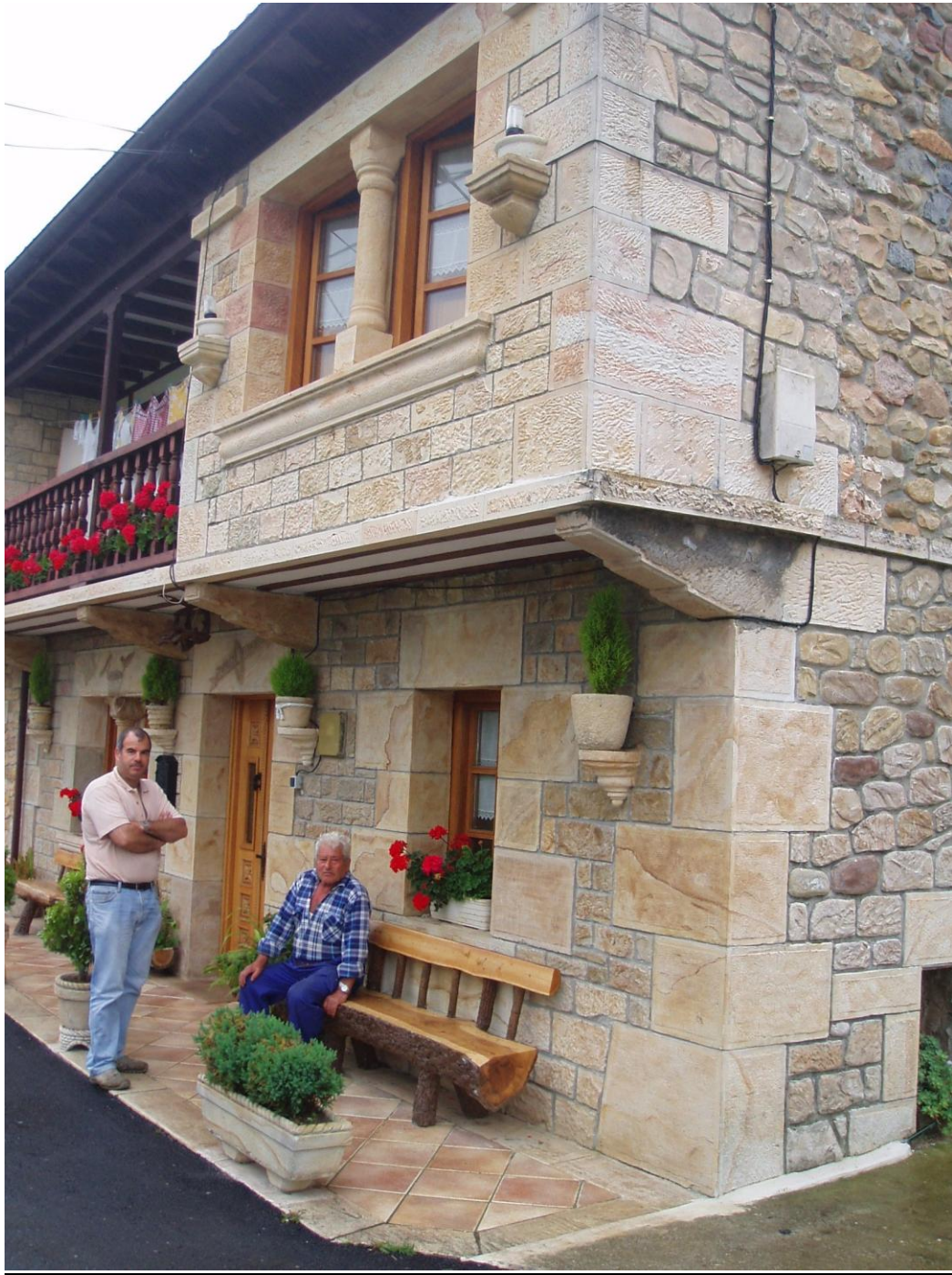
67-Chelo (izda.) y Juanito el Albañil, a la puerta de casa del segundo. Todo lo que parece sillería en la fachada está hecho con falsa piedra. Corvera.
