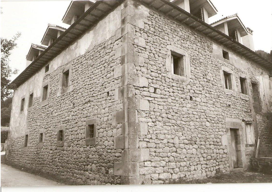
42-La posición correcta y perfectamente escuadrada de los sillares es fundamental para la distribución de fuerzas en la estructura del edificio y su sostenimiento. Casa natal del marino José de Bustamante y Guerra (siglo XVIII). Ontaneda (1998). Foto: JOSÉ MANUEL GONZÁLEZ CASTRO.
