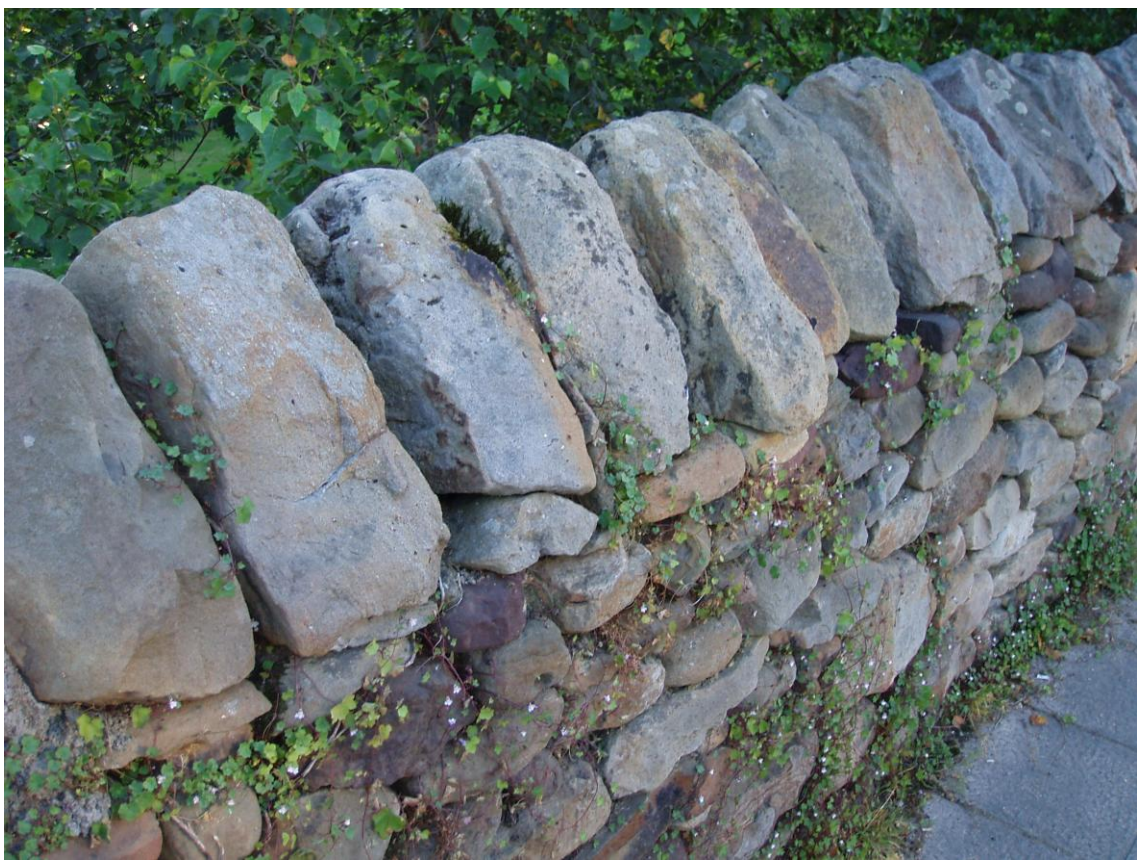
26-Detalle de cudones labrados triangulares a dos aguas como tope de pared en Selaya
