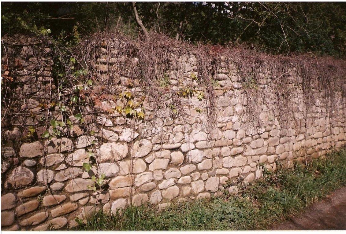
31-Muro perimetral con almenas de cudones. Penilla de Toranzo (1998).
