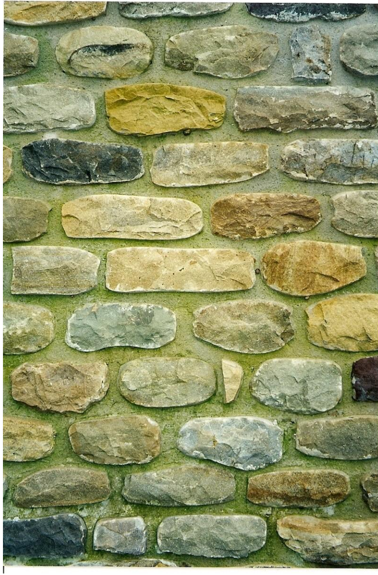
38-Piedras flotando. Se aprecia perfectamente la llaga entre los cudones. Penilla de Toranzo (1998).
