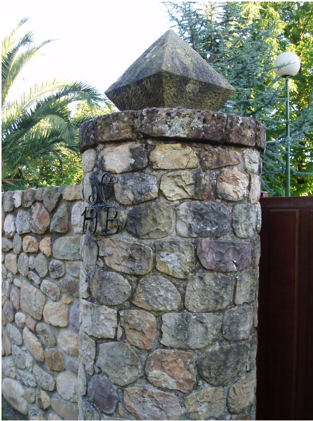
75-Machón delimitador de la portilla de entrada a una finca, construido con cudones y coronado por un diamante en sillería. Penilla de Toranzo.
