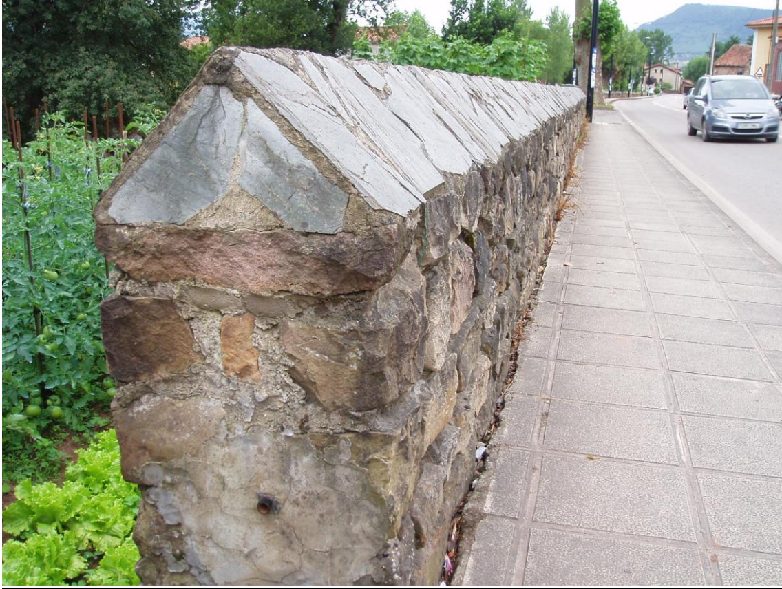
27-(Arriba) Caballete a dos aguas. Los Corrales de Buelna. 28-(Abajo) Idem. Arnuelo.
