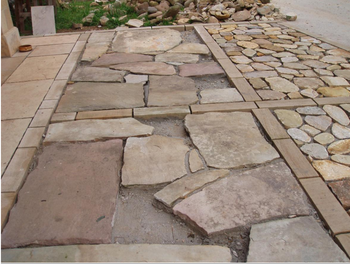
68-(Arriba) Suelo inconcluso de losas y de cudones careados. El Soto. 69-(Abajo) Suelo de cudones haciendo cuadros con aspas. Carmona.
