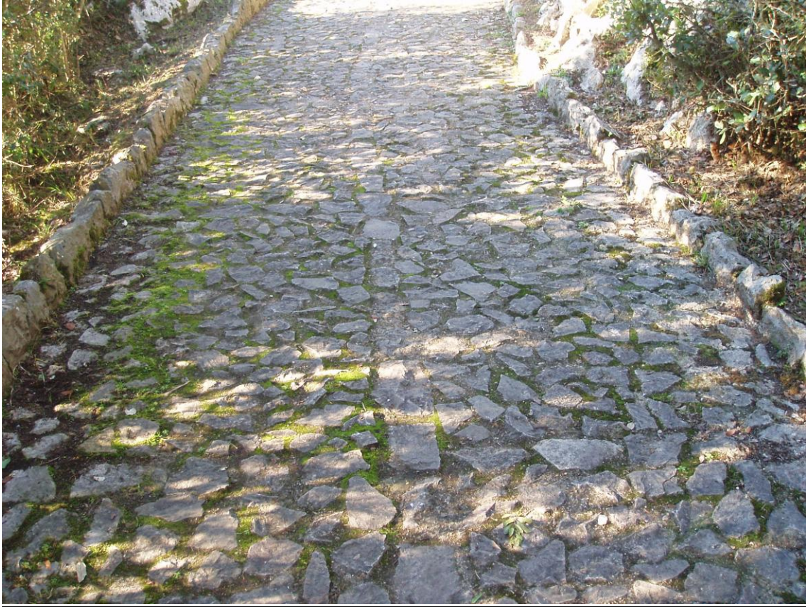
70-(Arriba) Suelo de plano dividido en caliza. Herrerías. 71-(Abajo) Suelo de arenisca formando una estrella. Carmona
