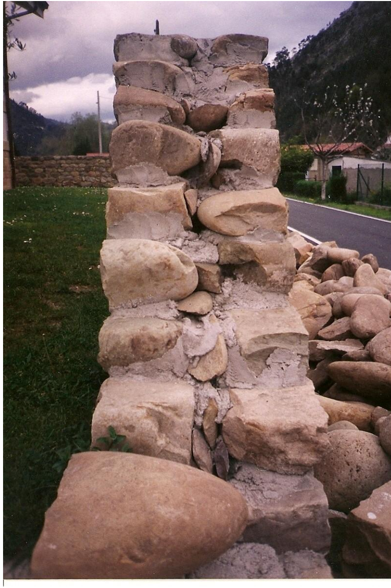
22-Corte vertical de una tapia a dos lienzos. Se puede apreciar la disposición de los cudones, con el careado hacia fuera, y el cascajo de relleno en medio. Penilla de Toranzo (1998).
