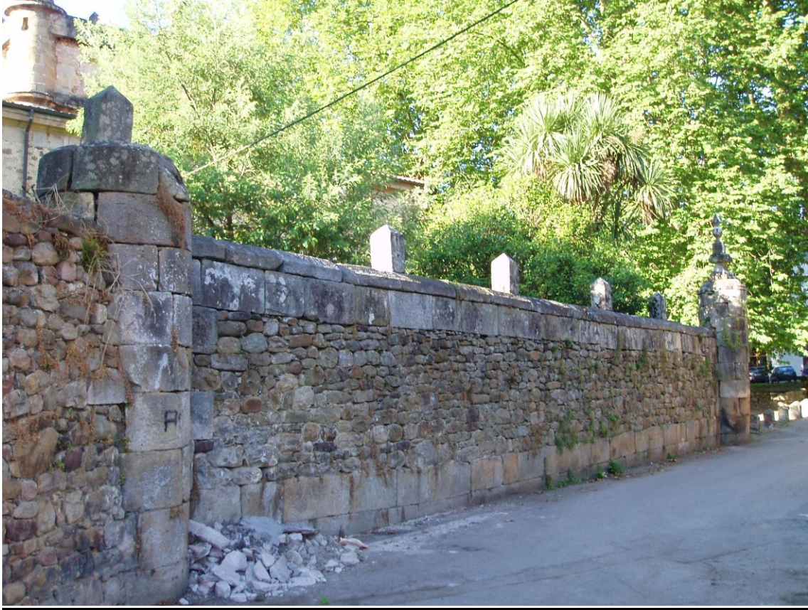
32-Muro fuerte de casa-torre. Selaya.
