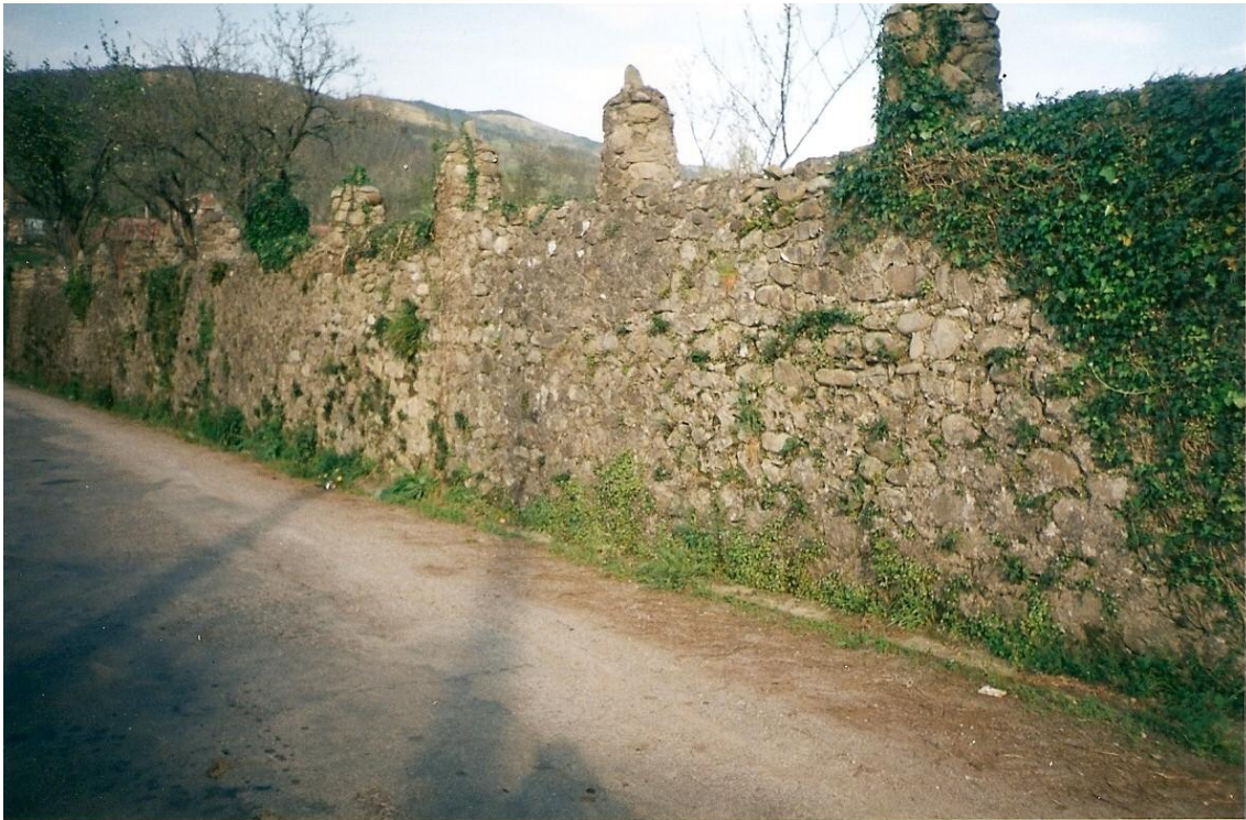
30-Muro con mochetas cilíndricas a modo de almenas. Soto-Iruz (1998).
