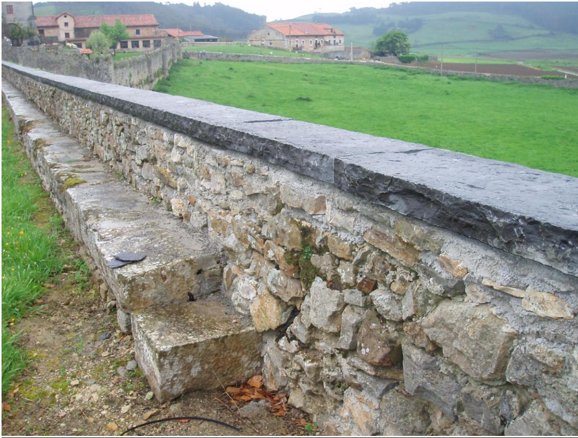
23-Tope de pared llano. Tapia construida con piedra caliza. Isla.
