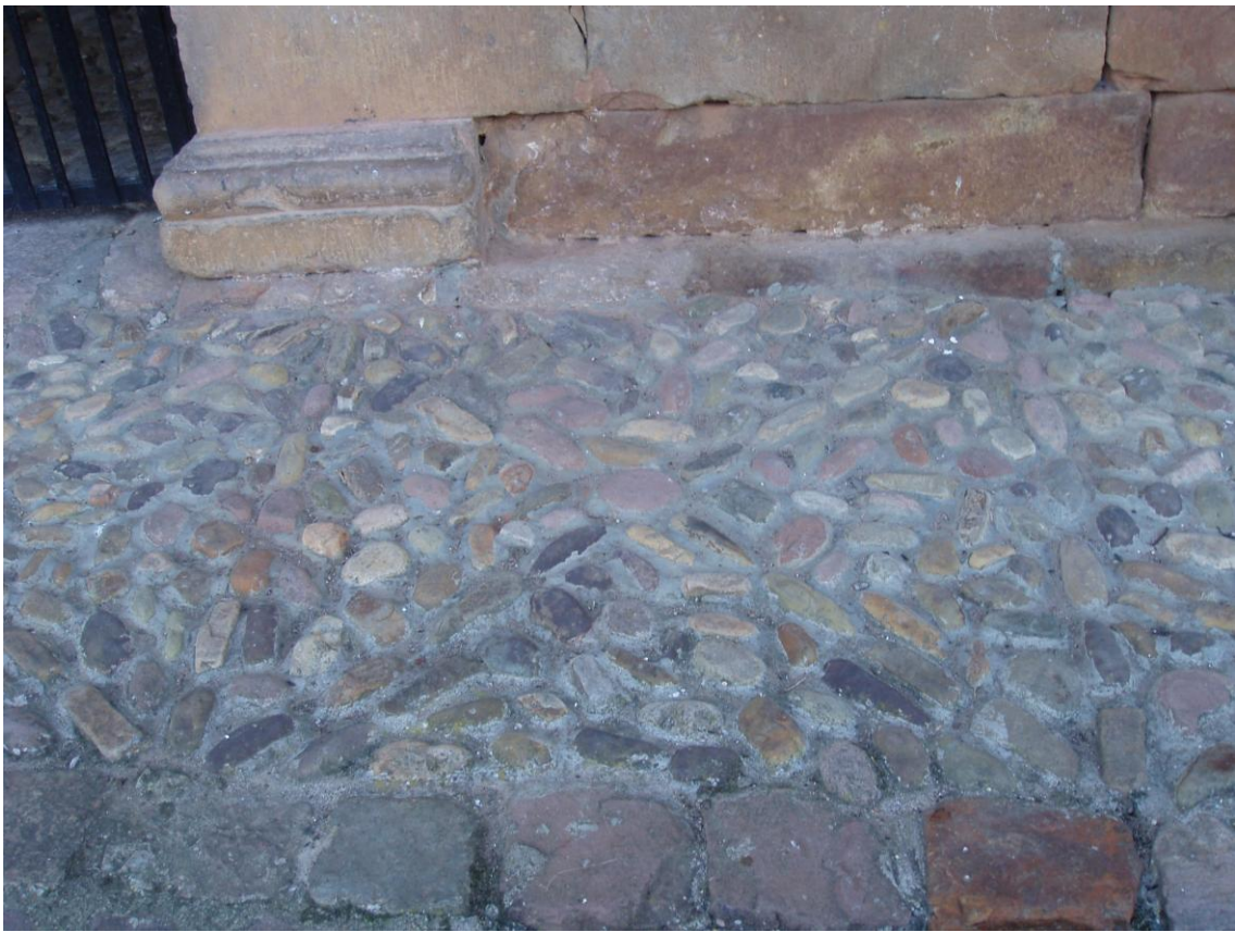
68-(Arriba) Suelo inconcluso de losas y de cudones careados. El Soto. 69-(Abajo) Suelo de cudones haciendo cuadros con aspas. Carmona.
