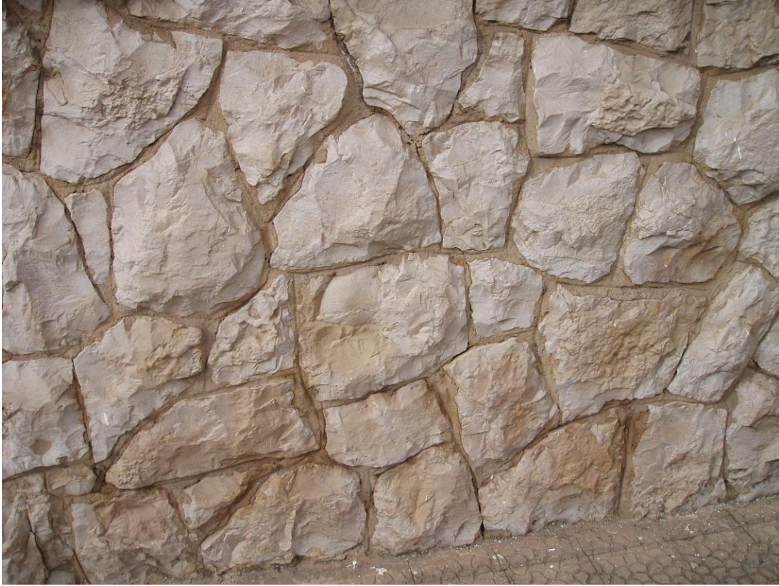
36-(Arriba) Aparejo concertado de caliza. Santander. 37-(Abajo) Aparejo caótico en el que no se ha cuidado la disposición y la piedra está mezclada. Orejo.
