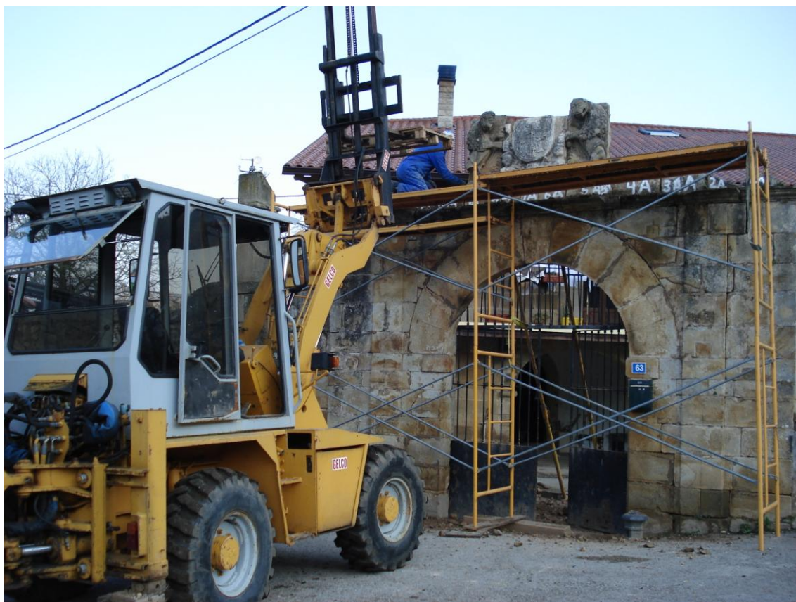
82-(Arriba) y 83(Abajo) proceso de restauración de una portalada: se enumeran las piedras, se desmontan, se sanea todo y se reconstruye de nuevo. Vejeorís.
