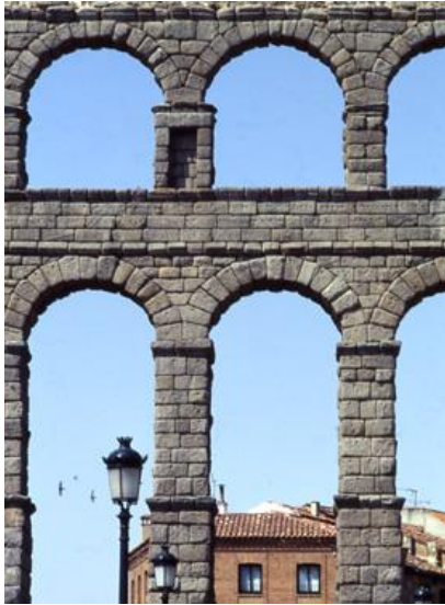
Fig. 9 Hilera de arcos en el acueducto de Segovia
