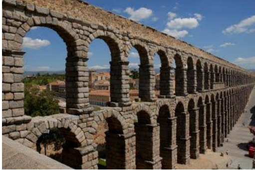
Fig. 5 Acueducto de Segovia
