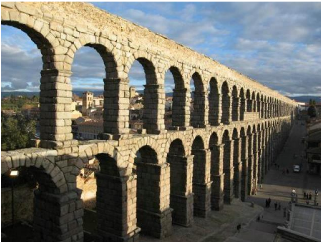
Figura 2.1 Acueducto de Segovia
