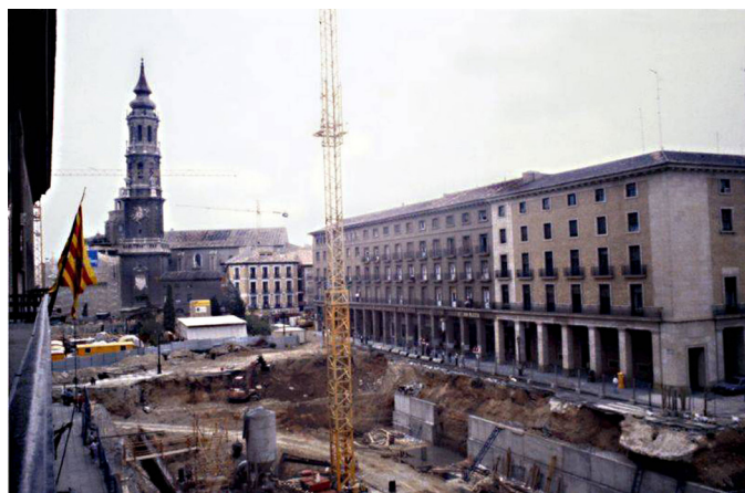
Figura 14: Obras de remodelación de la plaza del Pilar en 1991 (foto: elperiodicodearagón.com)
