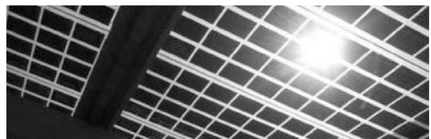
[3.04] [3.05] Módulo con estructura de doble vidrio.
