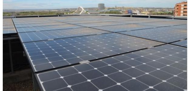
[4.32] Módulos de silicio cristalino en cubierta.
