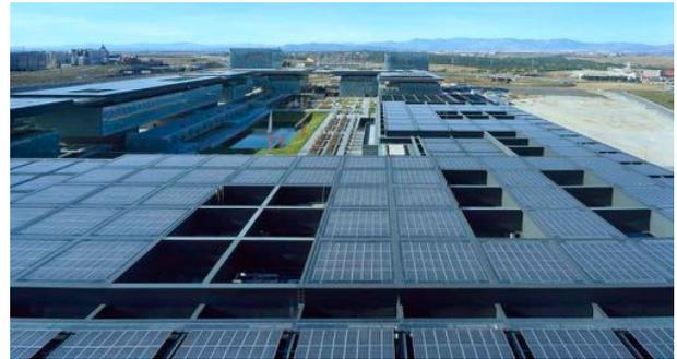
[3.59] Cubierta plana fotovoltaica en sede central de Telefónica.
