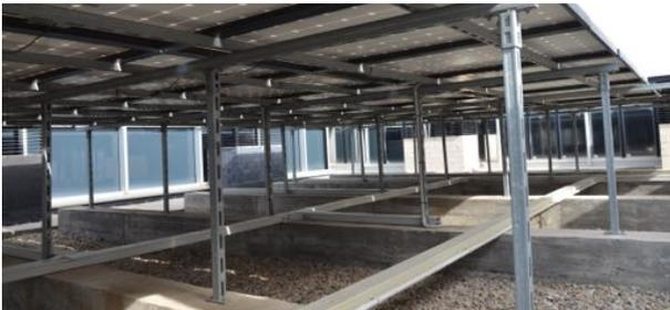
[3.54] Ejemplo de aplicación de módulos fotovoltaicos en cubiertas planas. CIEM.
