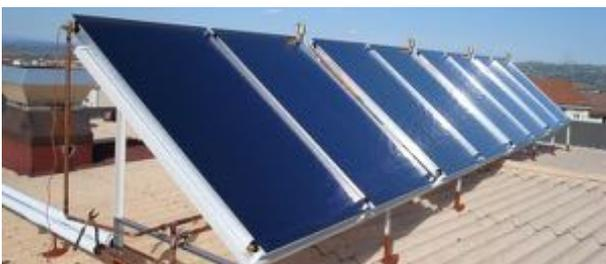
[1.07] Paneles solares de producción de ACS.
