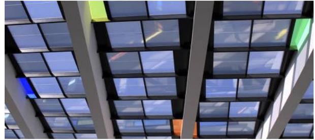
[3.56] Ejemplo de aplicación de módulos fotovoltaicos en un atrio.
