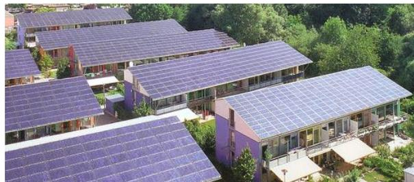
[3.51] Ejemplo de aplicación de módulos fotovoltaicos en cubiertas inclinadas.
