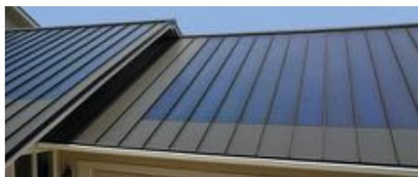
[3.52] Ejemplo de aplicación de módulos fotovoltaicos de silicio amorfo sobre cubierta metálica.
