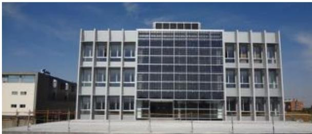
[4.20] Fachada Sur-Este que muestra los módulos de silicio cristalino semitransparentes.
