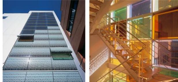
[3.29] [3.30] Fachada con vidrios serigrafiados en la parte baja y módulos de silicio amorfo semitransparente en la superior. Vista interior de la zona donde cambian.
