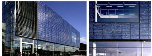
[3.19] [3.20] Manchester College of Arts and Technology, fachada ventilada y muros cortina de vidrio transparente y detalle de los módulos de silicio multicristalino.
