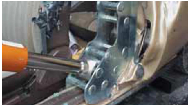
Figura AIII84. Instalación de soporte de cilindro como punto estable
