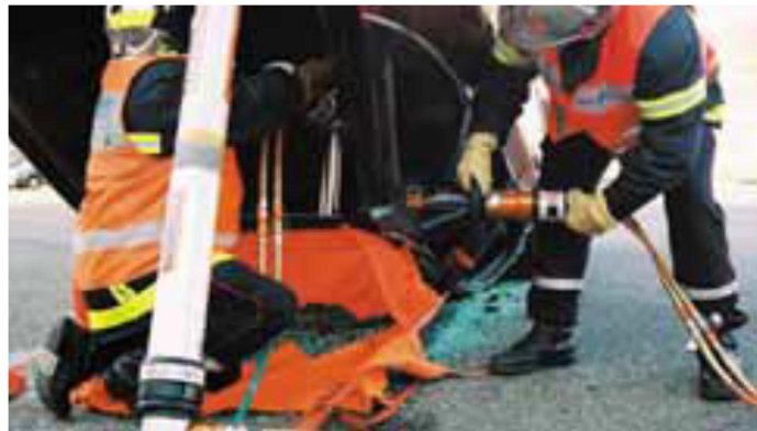
Figura AIII29. Colocación de cilindro y corte de poste B y C
