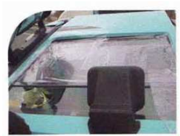
Figura AIII17. Protección de templados con lámina adhesiva
