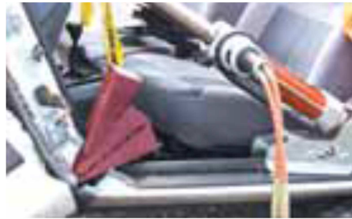
Figura AIII36. Colocación de cuñas en el corte de alivio
