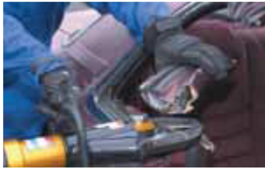
Figura AIII32. Eliminación del poste B
