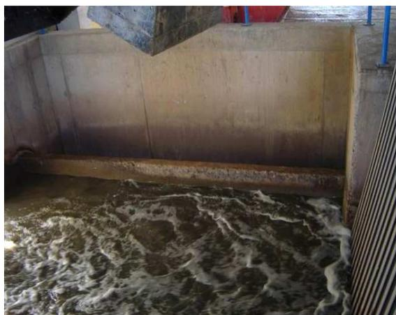
Figura 3.2 – Pozo de gruesos con canal by-pass lateral
