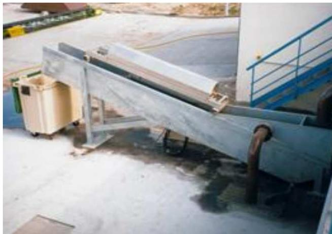
Figura 3.5- Tornillo sinfín de extracción de arenas
