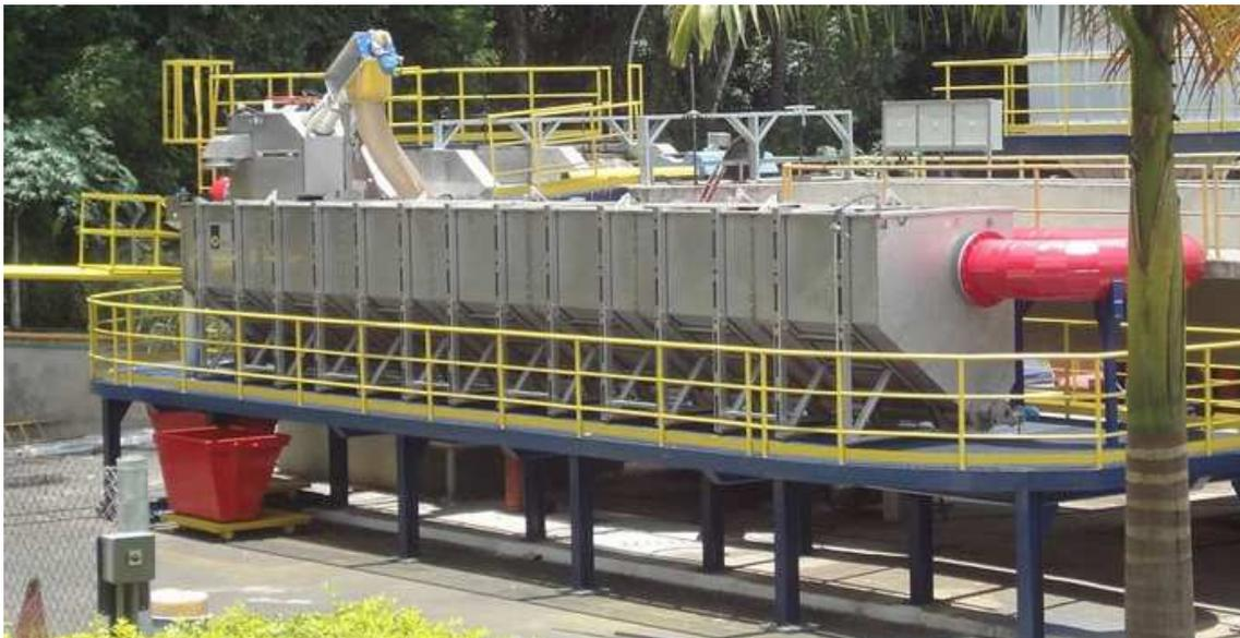
Figura 3.4- Planta de pretratamiento Speco TSF 3
