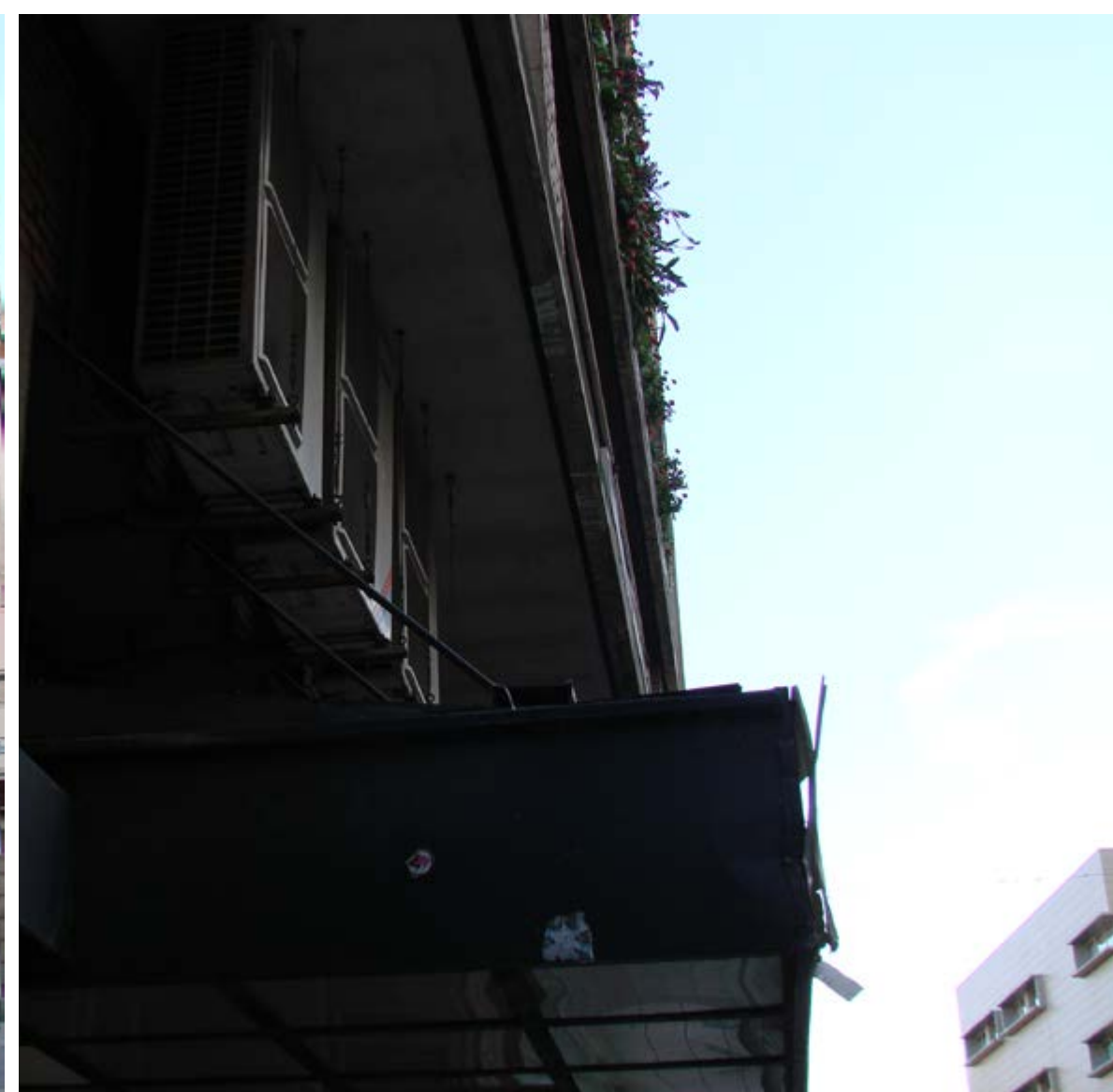
Calle Santo Domingo de Silos, Soria
