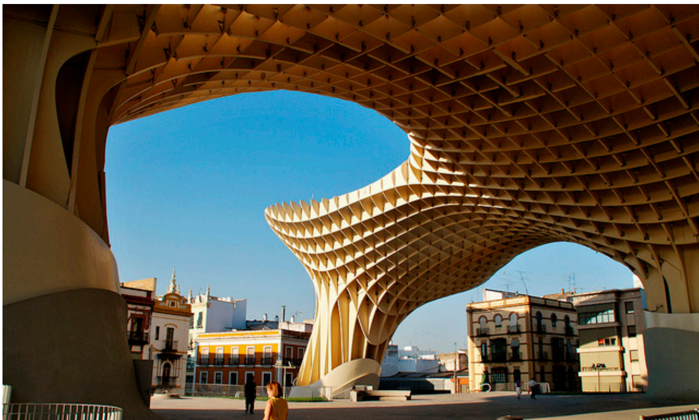
Fig. 21 - Metropol Parasol, en la Plaza de la Encarnación en Sevilla. Estructura realizada aplicando conceptos de fabricación digital. Realizado por el arquitecto Jürgen Mayer con la colaboración de Arup.
