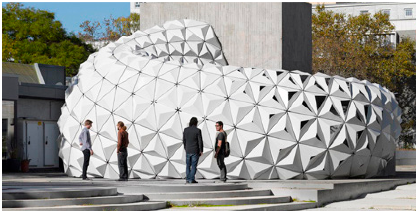
Fig. 51 - “ArboSkin - fachada de bioplástico” desarrollado por el Institute of Building Structures and Structural Design (ITKE) de la Universidad de Stuttgart - Alemania (2013)
