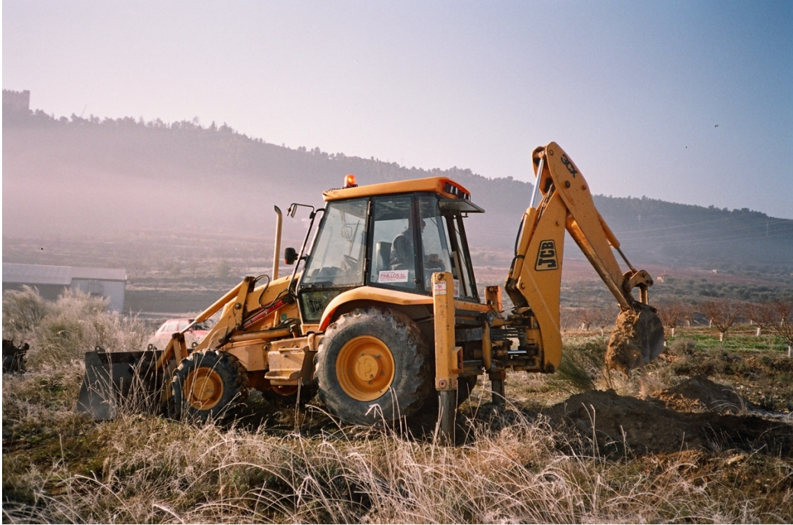
Foto 3. Retroexcavadora abriendo una calicata en la zona de estudio.
