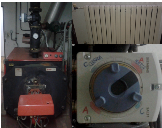
Figura20: Caldera, radiador y válvula de 3 vías.
