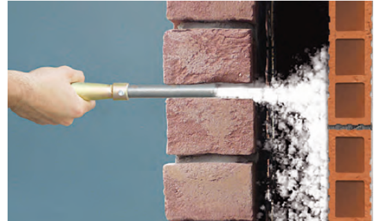
Figura 25: Imagen del relleno de la cámara Fuente : Knauf insulation[18].
