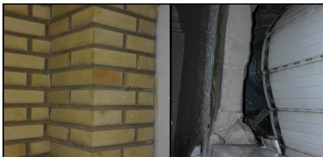
Figura 8: Muro de 400 mm y capialzado del hueco.
