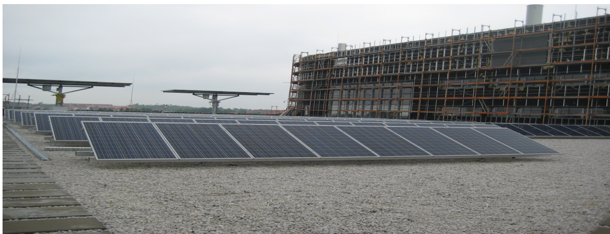
Figura 4.1.: Instalación de los 160 módulos fotovoltaicos en la azotea del DS1400
