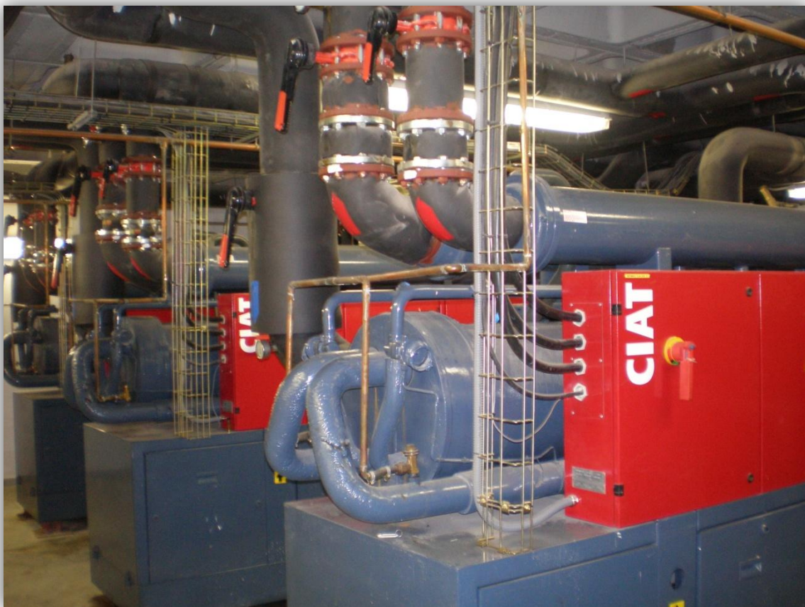
Figura 3.1. Fotografía de las tres plantas enfriadoras
