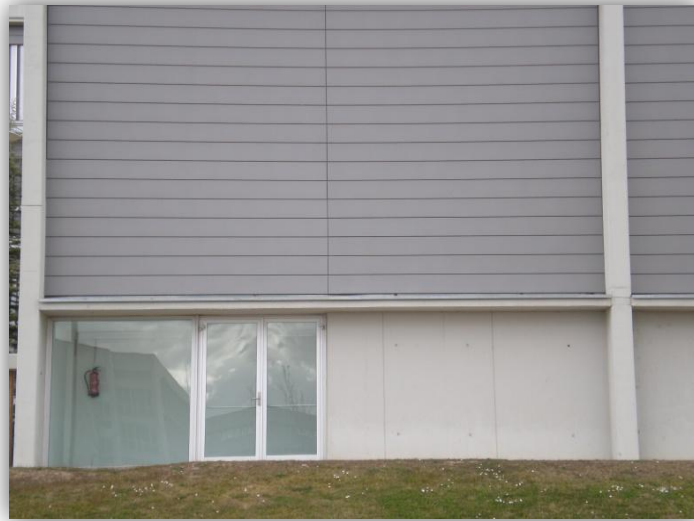
Figura 2.1. Imagen de la puerta de entrada a la zona de aulas situada más hacia el Este en la cara Sur
