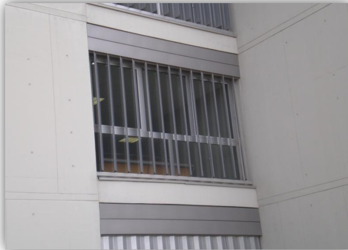
Figura 2.5. Fotografía de una ventana con lamas en la zona Oeste de despachos
