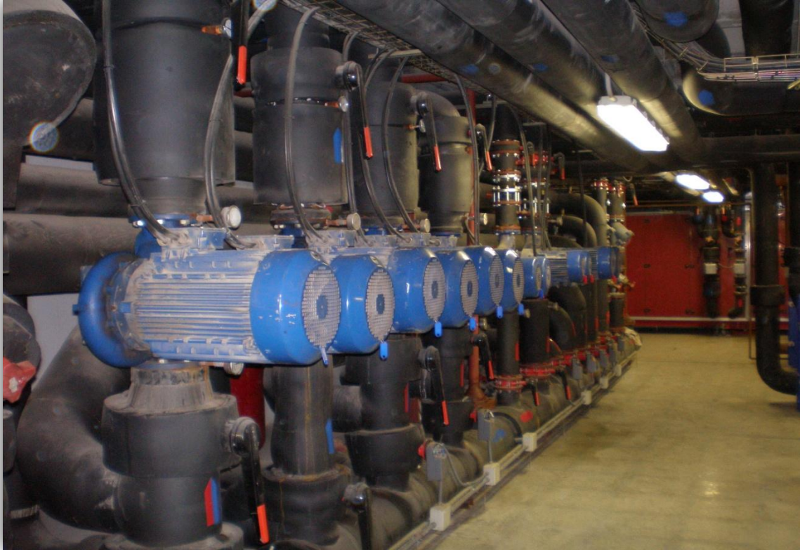
Figura 3.6. Fotografía de las bombas gemelas de secundario
