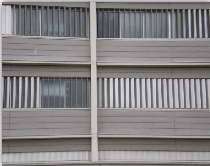
Figura 2.9. Fotografía de la parte delantera del edificio en su zona de aulas
