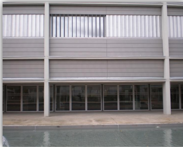
Figura 2.3. Fotografía de la cara Norte de la zona de aulas
