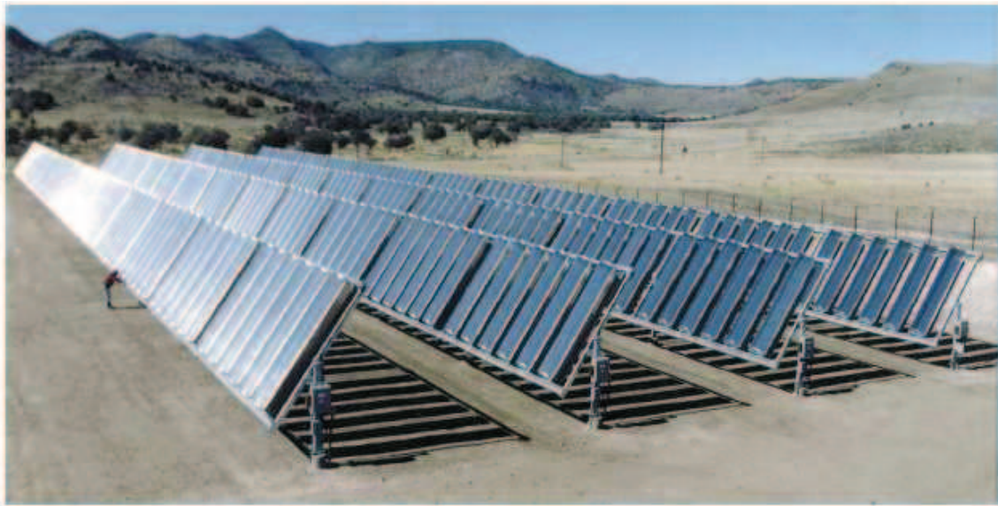
Figura 4. Planta fotovoltaica (concentrador constituido por lentes de Fresnel lineales arqueadas, Entech). Fuente NASA.
