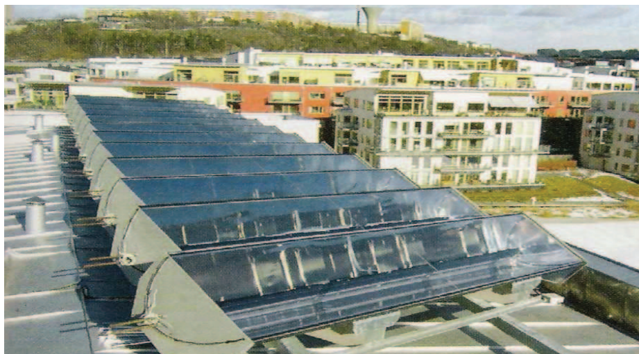
Figura 3. Instalación de concentradores parabólicos en un edificio con seguimiento a un eje.
