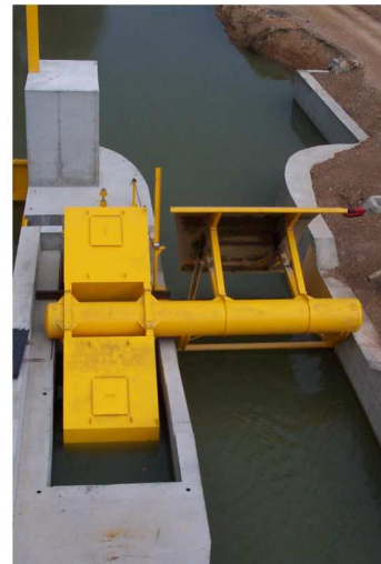
Figura 5.2: Ejemplo de una instalación de una compuerta Narmix
