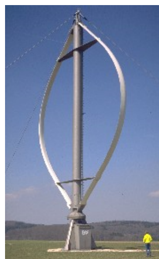
Imagen 8.3.6: Aerogenerador Darrieus de eje vertical. Fuente: Renovables-energía.
