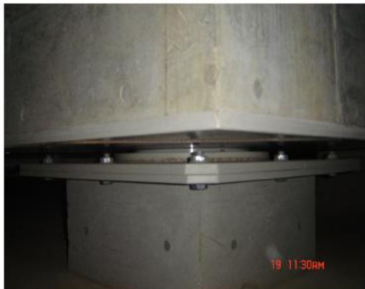
Aislador de fricción
