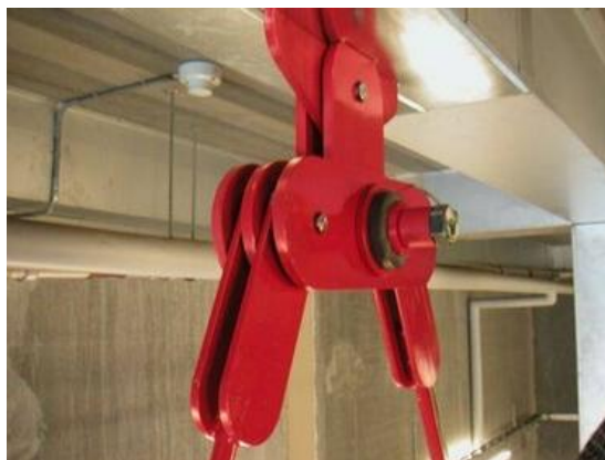
Disipador de Fricción por golillas
