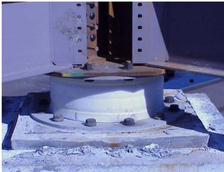
Apoyo Elastomérico
