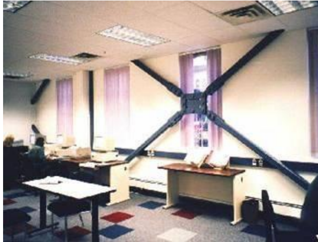
Disipador con sistema PALL
