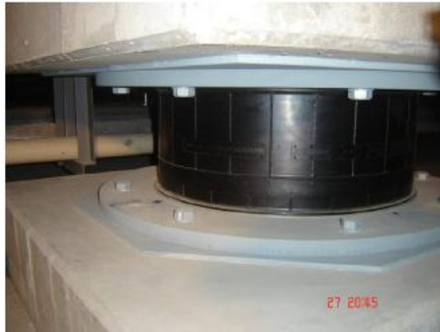
Aislador de caucho natural
