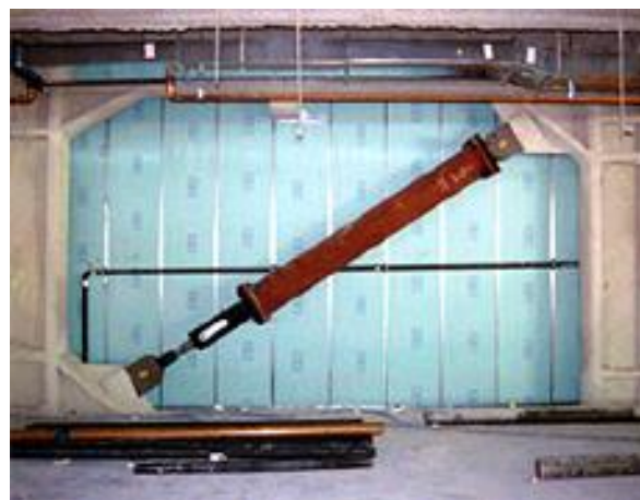
Amortiguador viscoso instalado en una estructura
