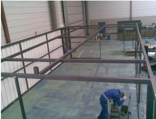
Figura 2.28. Construcción de la cabina de pintura
