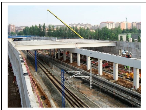
Figura 66. Cubrimiento de las vías en Miraflores. Año 2008. Fuente: Coalvi S.A
