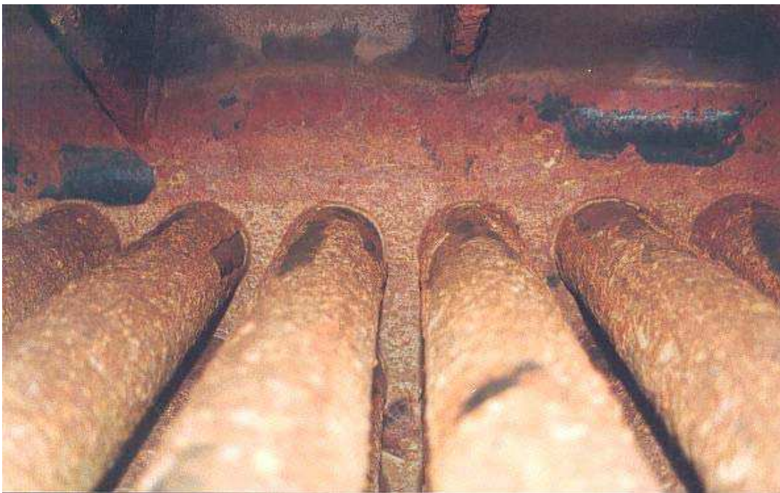
Figura 2.5 Incrustaciones en tubos de humo
