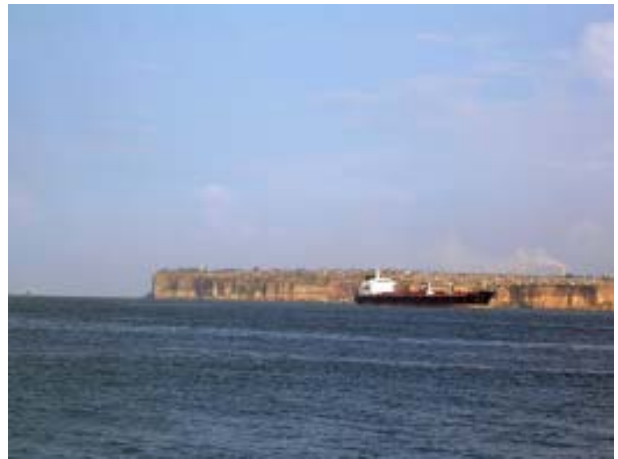
Figura 2.3.16. Vista desde la bocana W del puerto de Luanda de la otra bocana, en la que destacan acantilados de materiales de la formación pliocena Cacuaco-Luanda, constituida por margas y arcillas.
