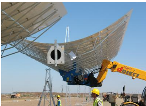
Figura 1.11. Montaje de los colectores cilindro parabólicos en el campo solar de la central Lebrija 1.
