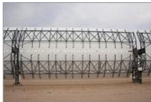
Figura 3.17. Parte de atrás de la estructura de un colector LS-3. (Fuente: http://www.nrel.gov/ )
