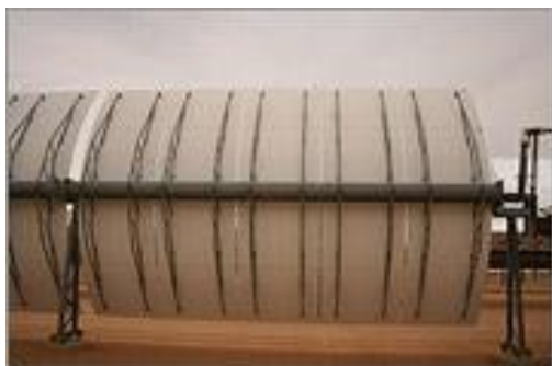
Figura 3.16. Parte de atrás de la estructura de un colector LS-2. (Fuente: http://www.nrel.gov/ )
