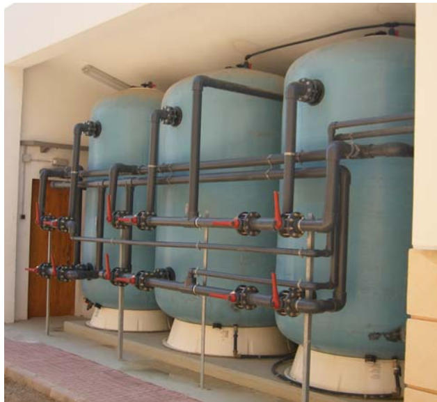
Figura 19: Fotografía de unos biofiltros de la tecnología UFBAF® (cortesía de Air Water Technologies)
