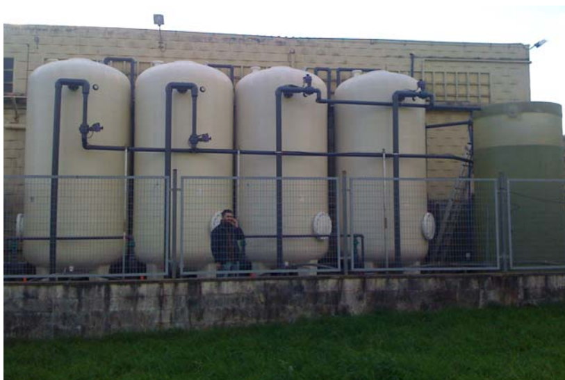
Figura 3: Instalación de biofiltración con la tecnología UFBAF®. (Cortesía de Air Water Technologies)
