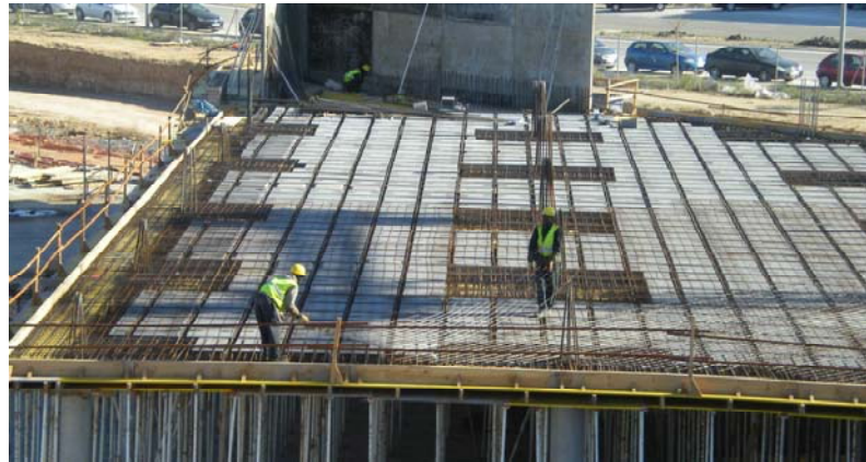
(2) Trabajadores montando forjado de edificio
