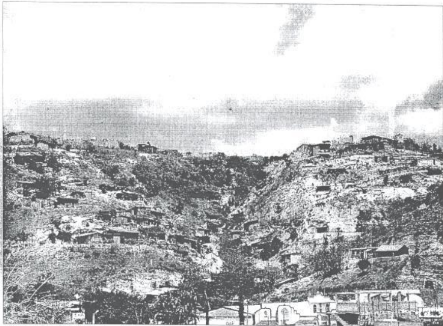
Aspecto de las numerosas viviendas que se siguen construyendo en laderas de cerros o en barrancas, consideradas de alto riesgo para la próxima temporada de lluvias. Los pobladores hacen caso omiso de los llamados de las autoridades a evacuar estas zonas. Foto Oscar Alvarado
