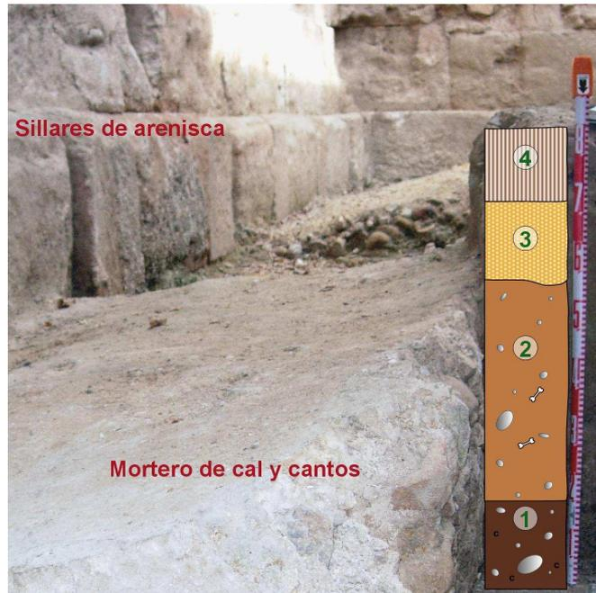
Fot. 152. Mortero de cal y cantos sobre el que se apoya el lienzo de la muralla y unidades diferenciadas en el corte estratigráfico.
