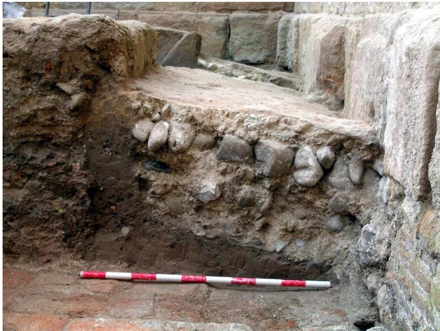
Fot. 151. Mortero de cal y cantos para cimentación de la muralla, suavemente inclinado hacia la misma. Atrás puede observarse los sedimentos en que se excavó la zanja de cimentación y el relleno posterior.
