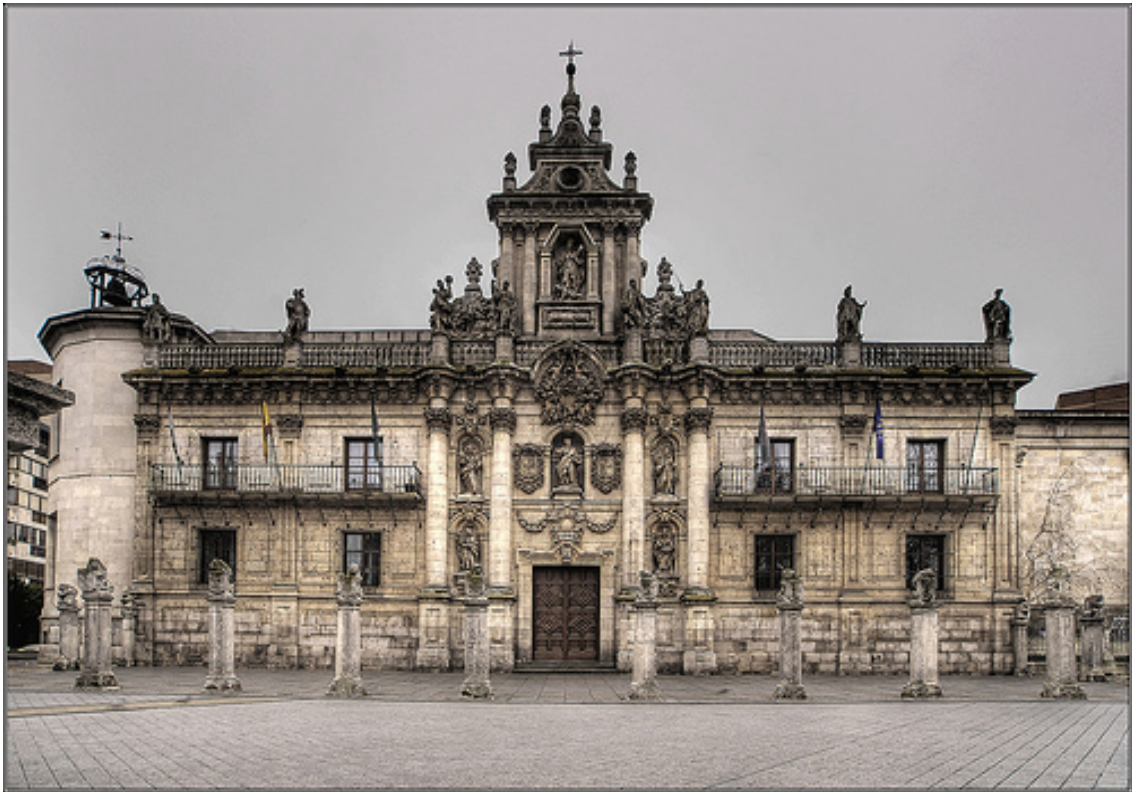
Fig. 4: Vista de la fachada barroca del edificio de la antigua Universidad de Valladolid (1715), actualmente Facultad de Derecho. Foto: Archivo de la autora.
