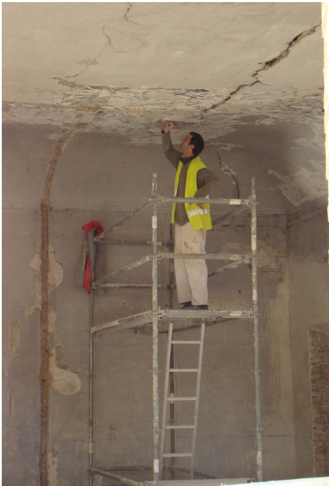
Fig. 131: Detalle de los trabajos en la bóveda de las estancias privadas durante la restauración, Palacio arzobispal de Zaragoza. Foto: Carmen Morte García.
