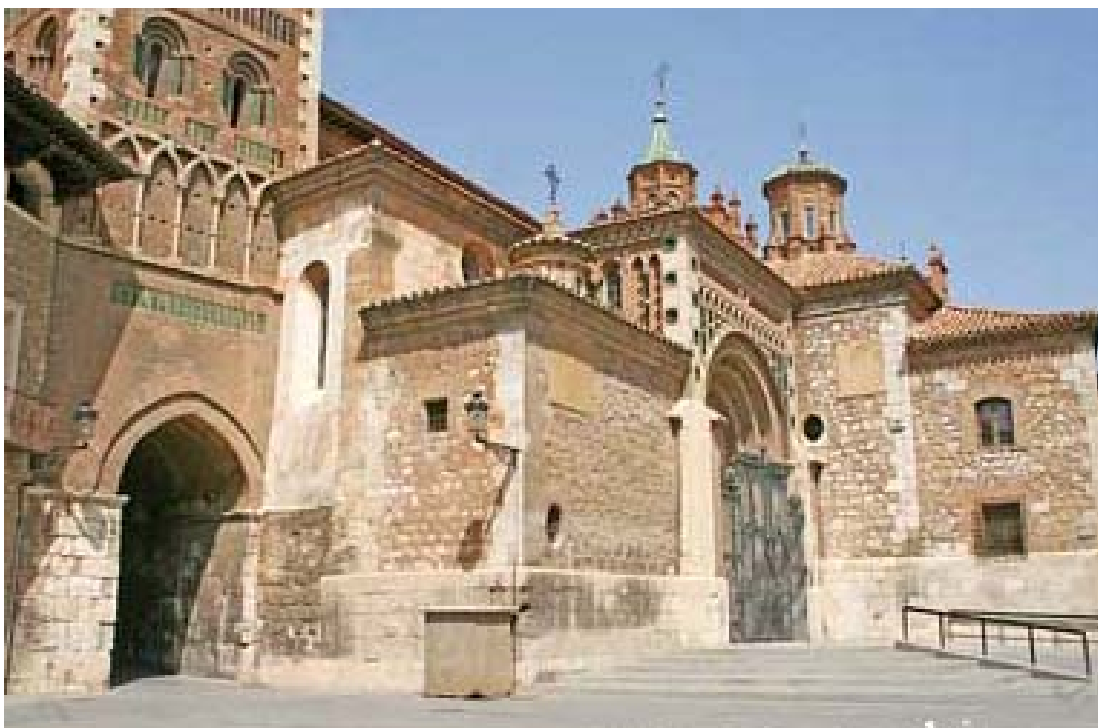
Fig. 19: Vista exterior de la catedral de Santa María de Mediavilla (Teruel). Foto: archivo de la autora.
