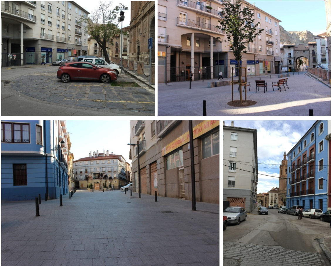
Imagen 10. Fotografías comparativas entre el antes y el después de recientes transformaciones llevadas a cabo en el espacio público del Casco Histórico. Apuesta por el diseño con criterios de accesibilidad y movilidad sostenible, ejecutando secciones de plataforma única y reduciendo el aparcamiento en superficie al reservado para residentes y carga y descarga.
