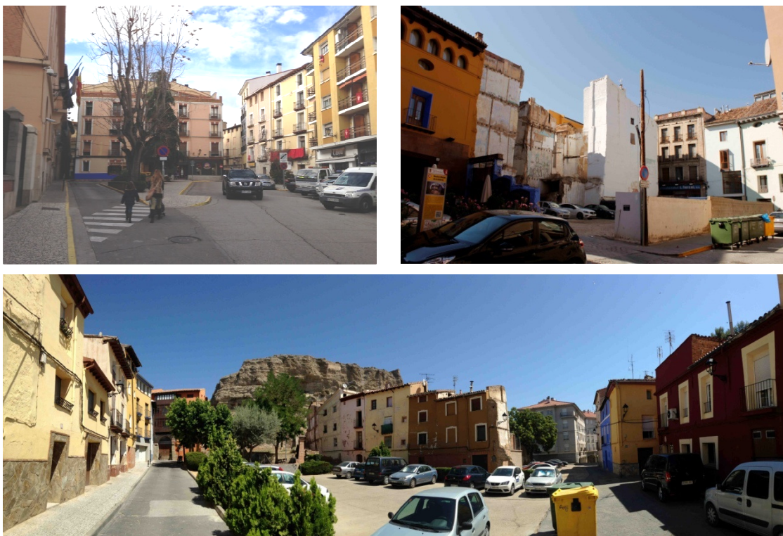
Imagen 9. Aspecto habitual de las calles del Casco Histórico de Calatayud, con excesivo uso del espacio público como aparcamiento del vehículo privado, mal estado de conservación de las edificaciones, presencia de solares vacíos y bajo nivel de calidad en la urbanización.
