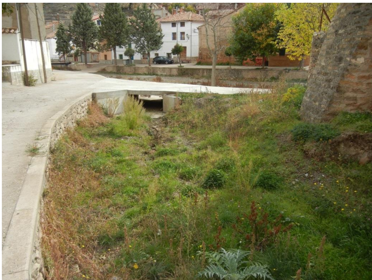
Figura: Sección barranco de la margen izquierda en el municipio de La Hoz de la Vieja con pequeño paso entubado al fondo
