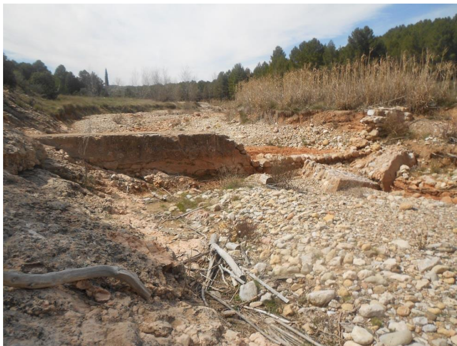
Figura: Azud destruido en el tramo del valle abierto de Oliete
