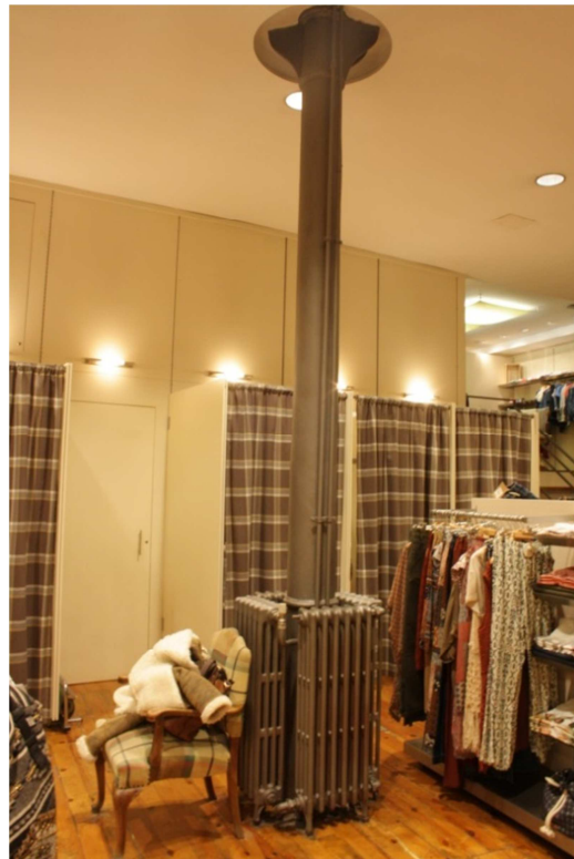
Figura 16. Pilares originales de fundición de hierro en la planta comercial de la Casa Ferrán (Fotografía: autora).
