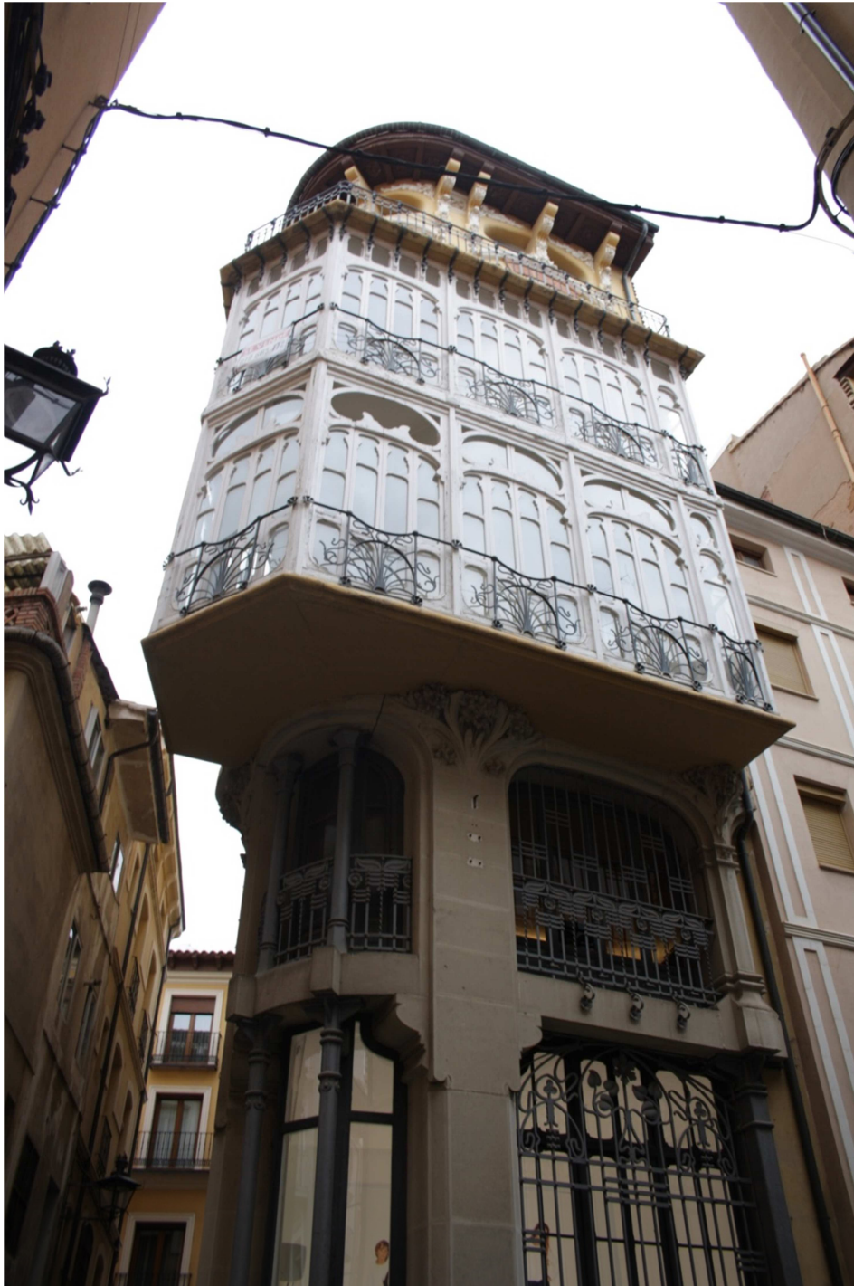
Figura 25. Detalle del mirador de la Casa Ferrán que se sitúa en la esquina achaflanada, entre la calle Nueva y el callejón Pozo, que conduce hacia la calle El Salvador (Fotografía: autora).
