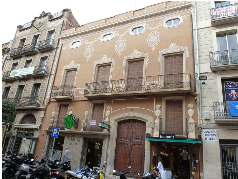
Figura 4. Vista general de la Casa Massó en Reus, sin fecha concreta de su intervención (Fuente: https://ca.wikipedia.org/wiki/Casa_Mass%C3%B3 ) (Fecha de consulta: 19-V-2016).
