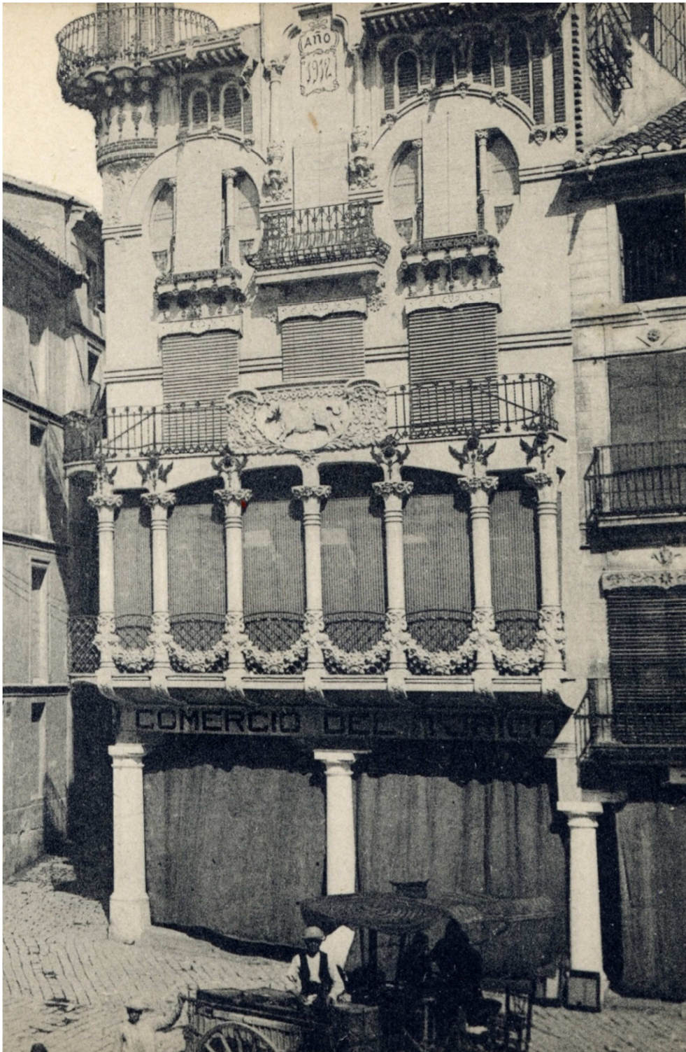
Figura 41. Fachada de la Casa de Tejidos de Teruel, diez años después de su construcción, donde se aprecia la decoración en yeso del torico y las persianas de los vanos de la vivienda (Fuente: Antonio Pérez Sánchez).
