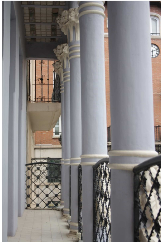
Figura 33. Detalle del balcón corrido de la primera planta de la Casa de Tejidos El Torico de Teruel (Fotografía: autora).
