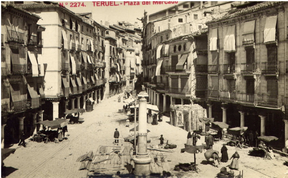
Figura 46. Fotografía de la construcción de la Casa de La Madrileña, h. 1912, en la plaza de Carlos Castel (Fuente: Antonio Pérez Sánchez).
