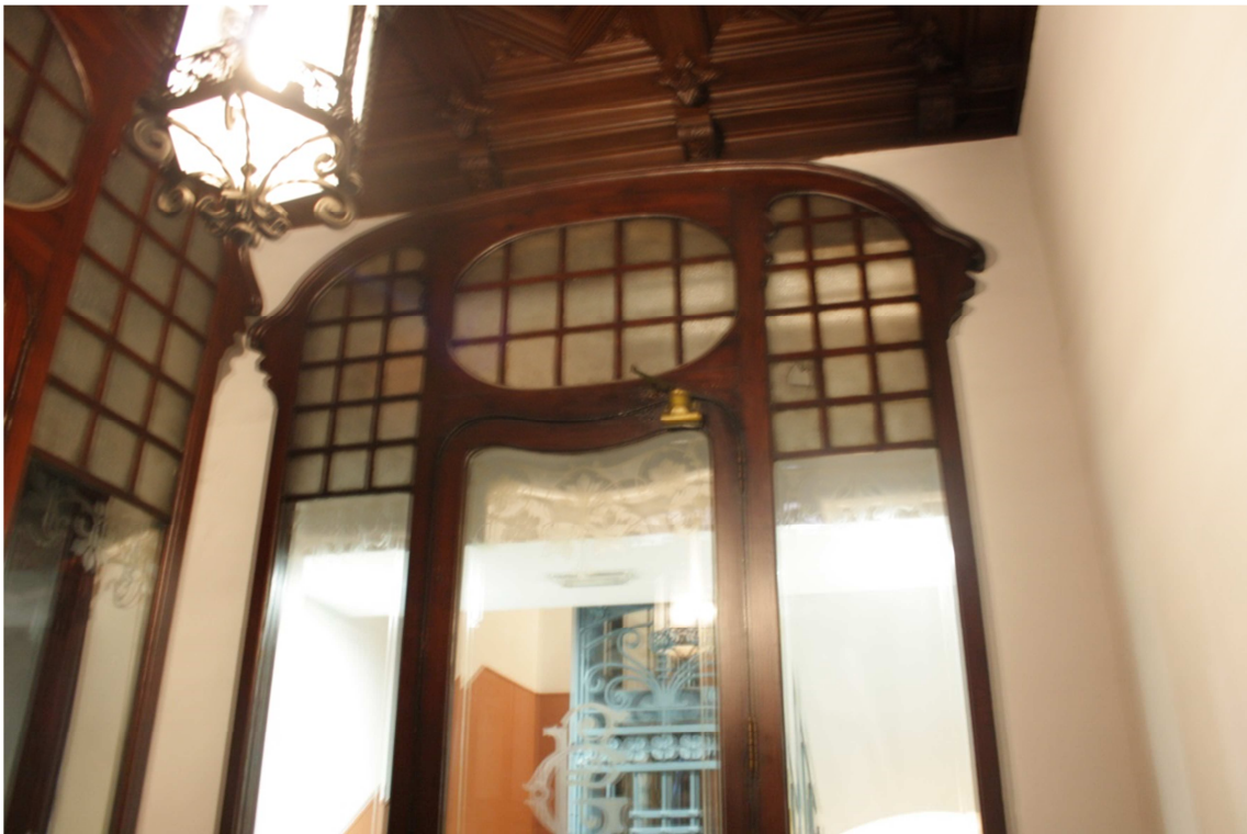
Figura 27. Detalle de la cancela del vestíbulo y el cerramiento de la portería, en el interior de la Casa Ferrán (Fotografía: autora).
