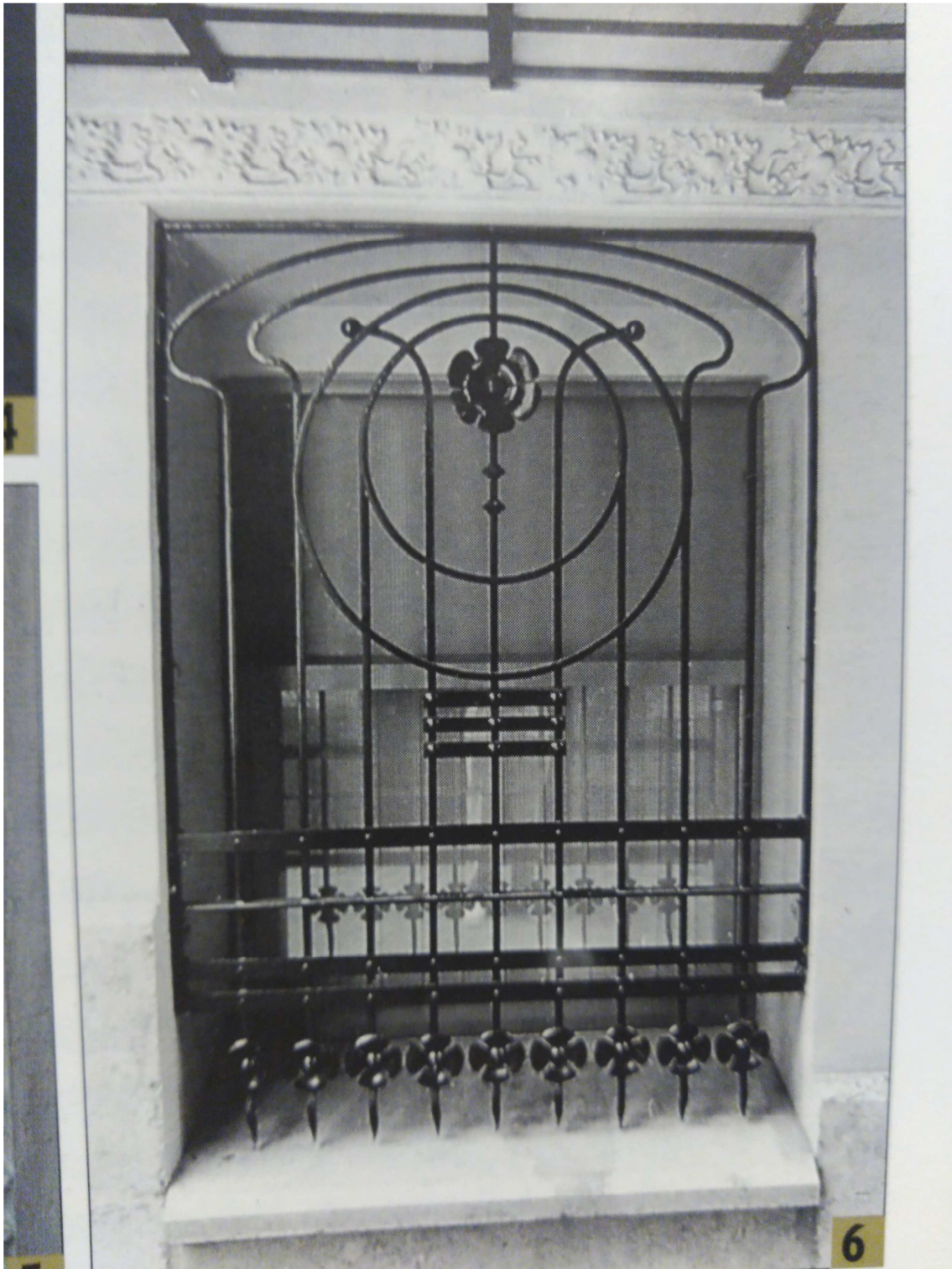
Figura 44. Detalle de los vanos de la fachada lateral de la Casa de Tejidos El Torico, en la calle Hartzzenbusch (Fuente: Antonio Pérez Sánchez).
