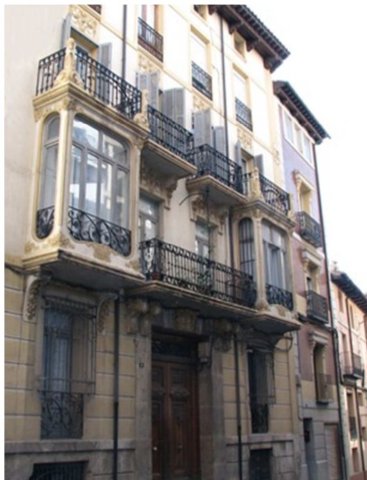
Figura 8. Fachada principal de la Casa de Natalio Ferrán en la calle San Francisco, número 7, Teruel, 1914 (Fuente: http://www.teruelirwal.es/teruel/fotos_teruel_actual.html ) (Fecha de consulta 19-V-2016).
