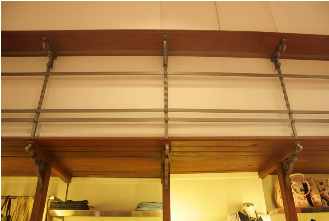
Figura 31. Pasadizos de fundición con rejería original. Interior del comercio de la Casa Ferrán (Fotografía: autora).
