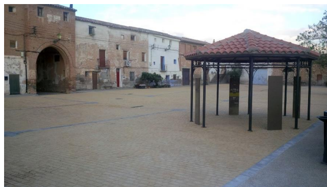
Ilustración 56. Monasterio de Santa Fe de Huerva (vista plaza rehabilitada). Fuente: APUDEPA.
