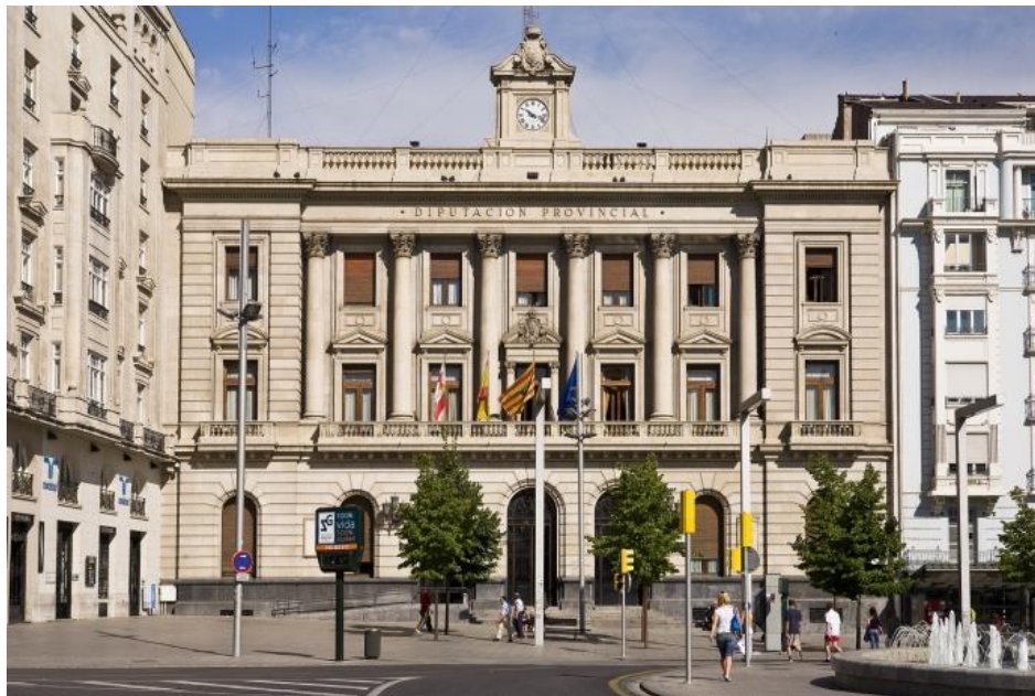
Ilustración 35. Fachada principal de la actual sede de la Diputación Provincial de Zaragoza. Fotografía: Web de la DPZ.
