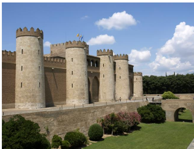
Ilustración 48. Palacio de la Aljafería. Fotografía propia.
