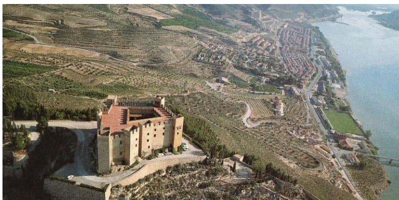
Ilustración 59. Castillo de Mequinenza visto desde el aire. Fuente: Captura de pantalla de Youtube.
