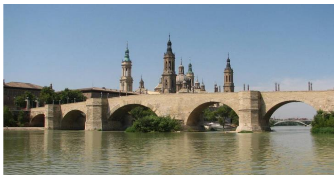
Ilustración 43. Puente de piedra. Imagen tomada desde la margen izquierda del Ebro.
