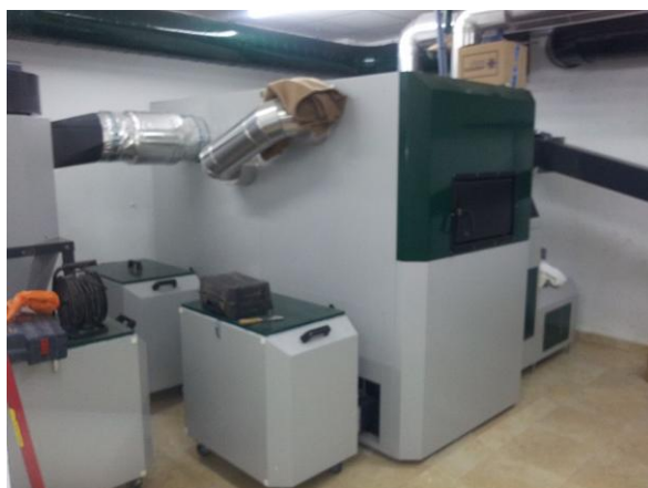
Ilustración 3. Caldera de biomasa. Fuente: https://vimeo.com/user11760379/videos/all
