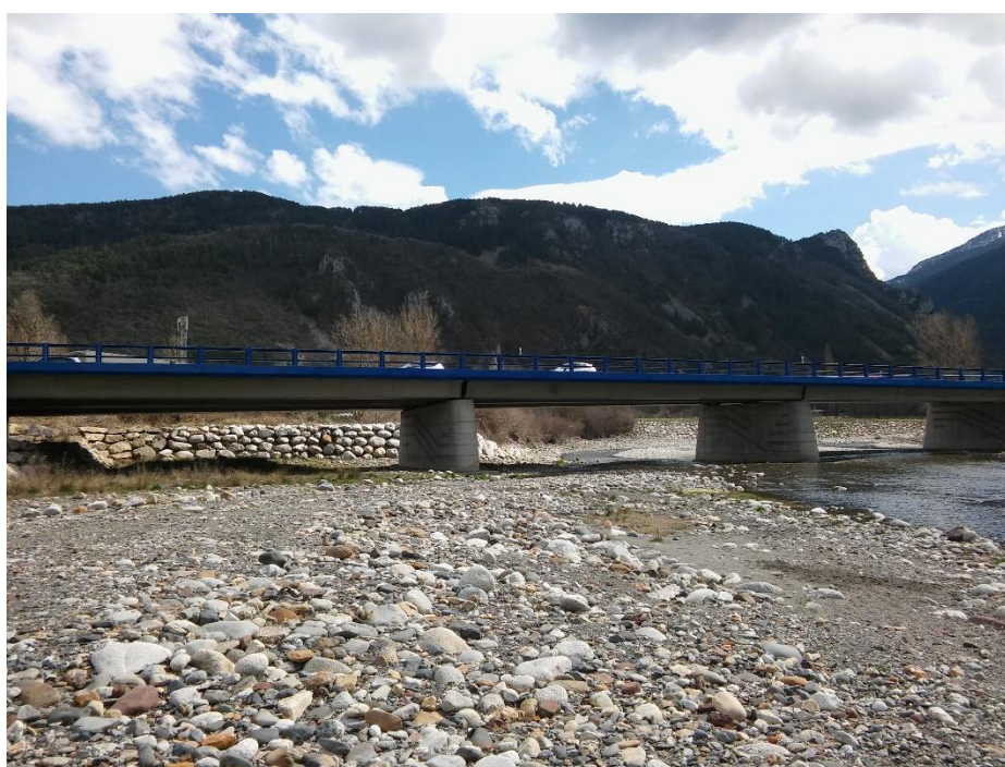
Ilustración 25. Escolleras en el municipio de Castejón de Sos
