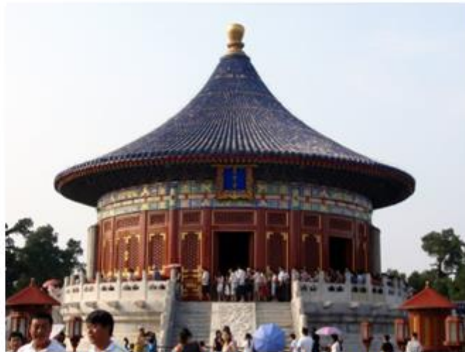
Ilustración 16. Exterior de la bóveda del cielo.
