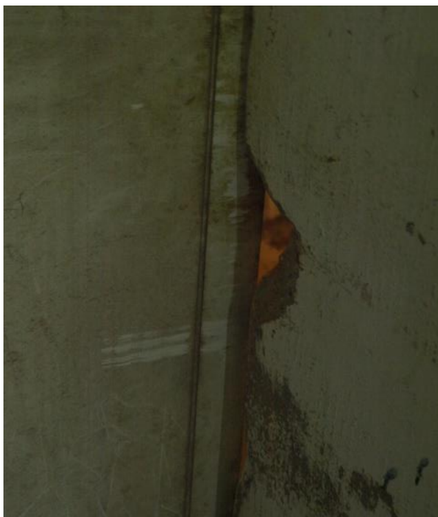
Figura 18. Entrada parásita de aire.
