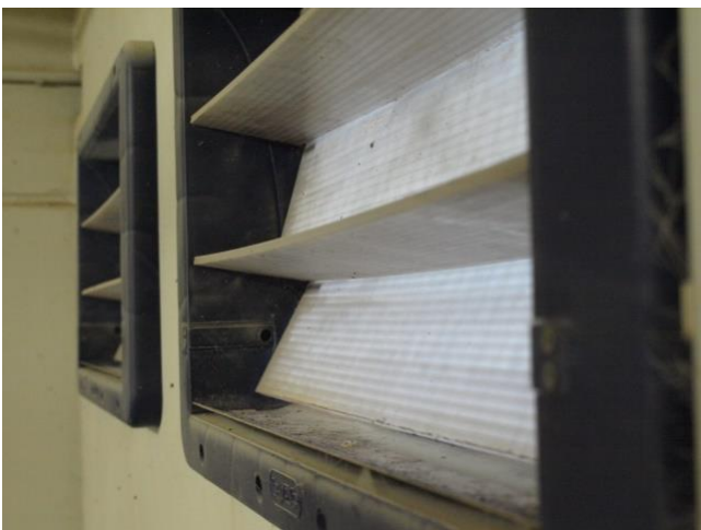
Figura 11. Sección de entrada de aire en una de las ventanas de la sala.
