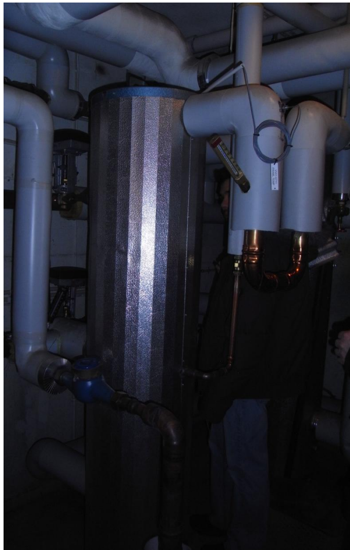
Figura 24. Intercambiador de calor de calefacción
