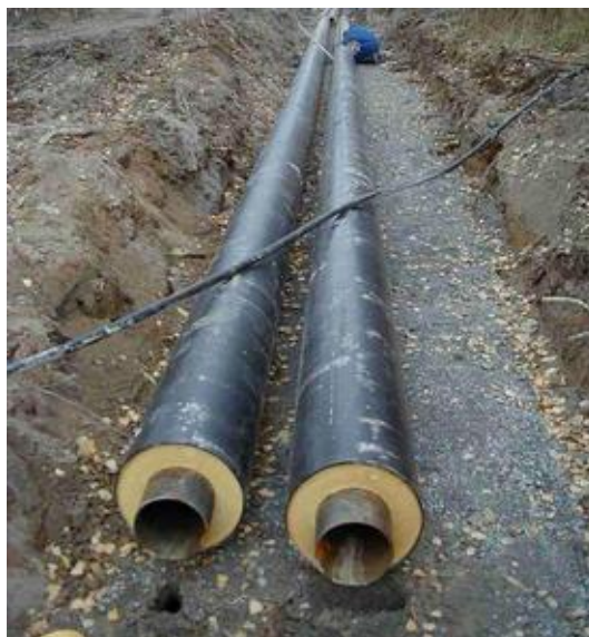
Figura 21. Tuberías de distribución de district heating (II)
