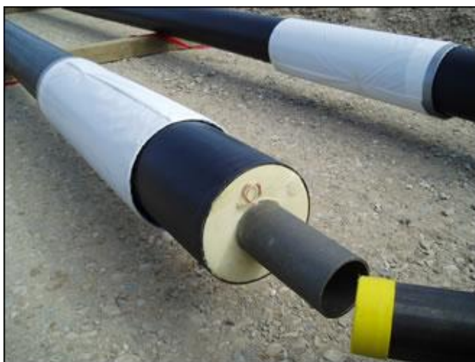
Figura 20. Tuberías de distribución de district heating (I)
