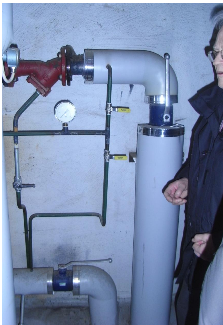
Figura 22. Tubería suministro district heating
