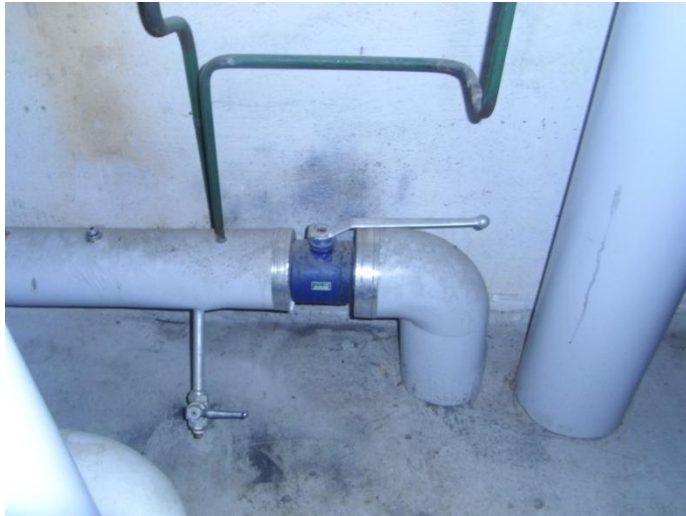
Figura 23. Tubería de retorno de la red district heating
