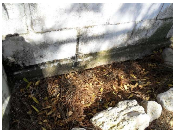
Apoyo de la solera de hormigón en el terreno
