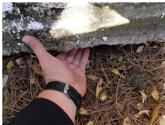
Detalle del apoyo de la solera
