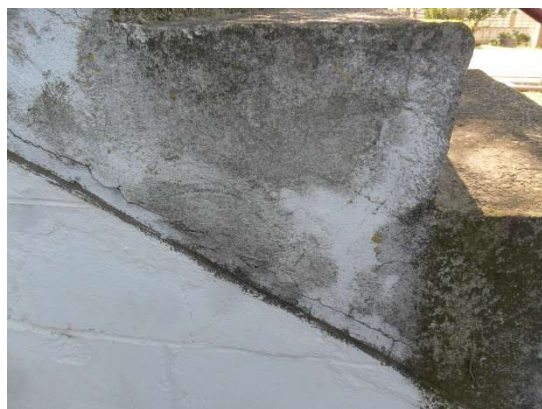
Detalle del encuentro del muro norte y la zanca
