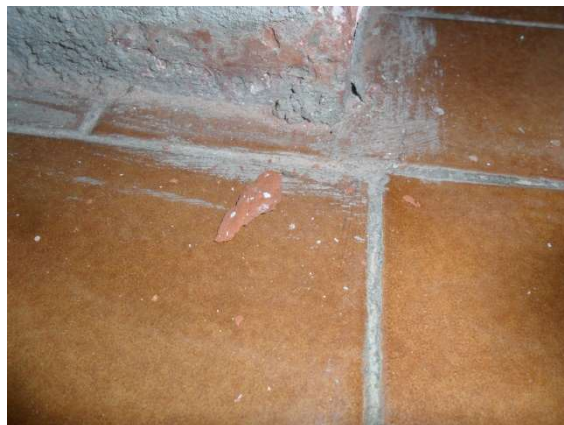
Detalle desprendimiento de ladrillo
