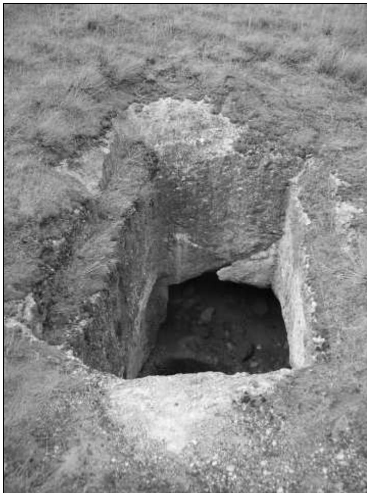
Aljibe de la Torre de Martín González, situado en el recinto murado anexo a la misma.
