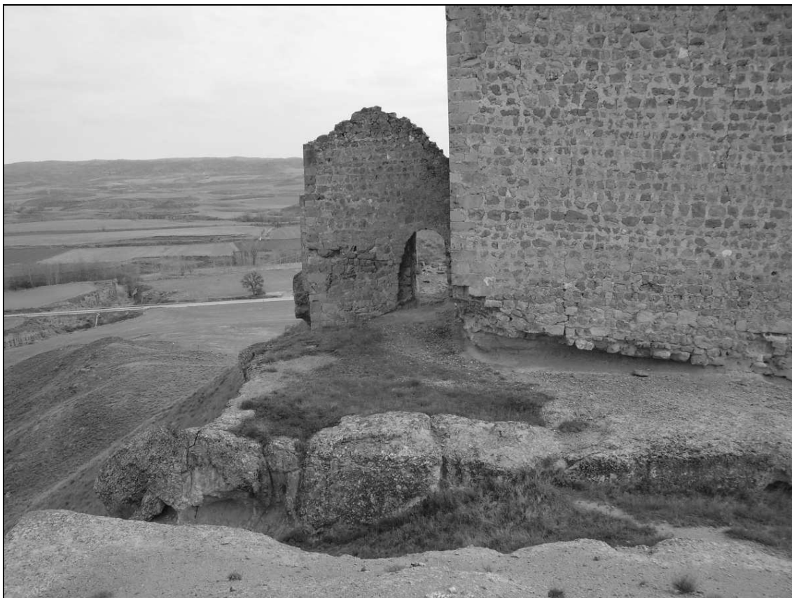
Acceso al recinto fortificado de la Torre de Martín González, donde se puede observar el foso (cava o valla) excavado en la roca.
