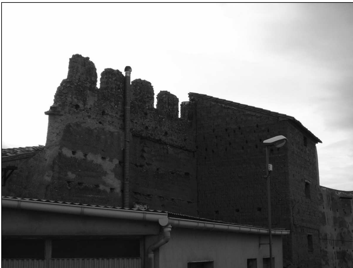
Ejemplo de construcción contigua a una muralla, hacia su parte externa, en Villarroya de la Sierra (Zaragoza).
