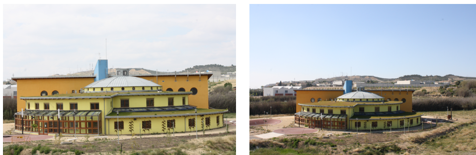
Figura 4.13. Vista general del edificio CIRCE
