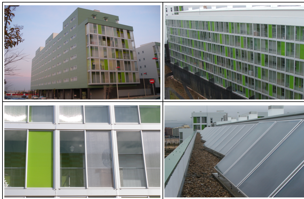
Figura 4.5. Imágenes del edificio n° 1 objeto del estudio: Fachadas norte y sur (arriba) y detalle de los invernaderos y captadores solares térmicos del edificio (abajo)
