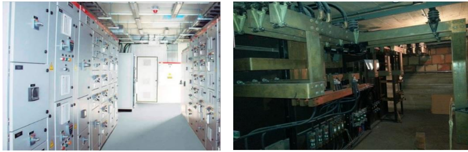
Figura 4 - Encerramiento walk-in y NON walk-in.
