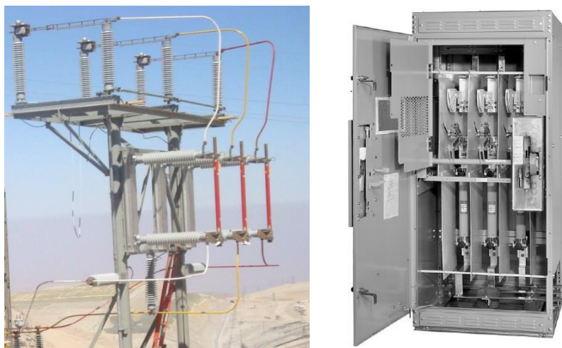
Figura 6 - Aparamenta eléctrica exterior e interior.
