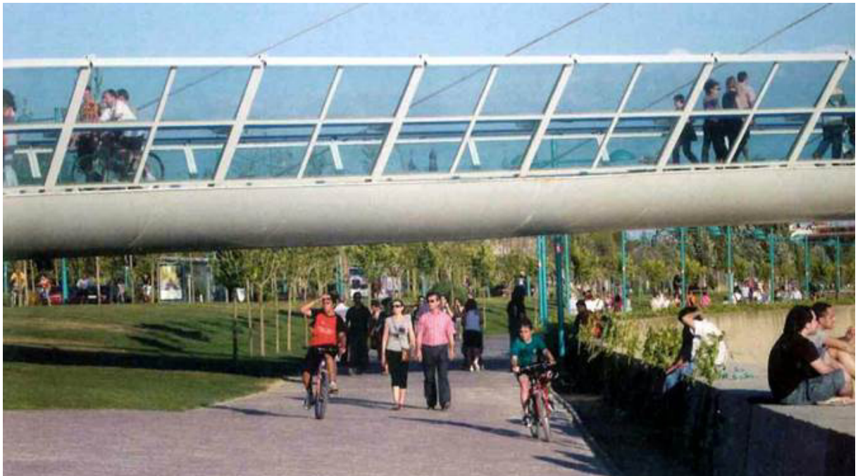
Figura 18. Ebro_Espacios públicos. Pasarela Voluntariado_Manterola
