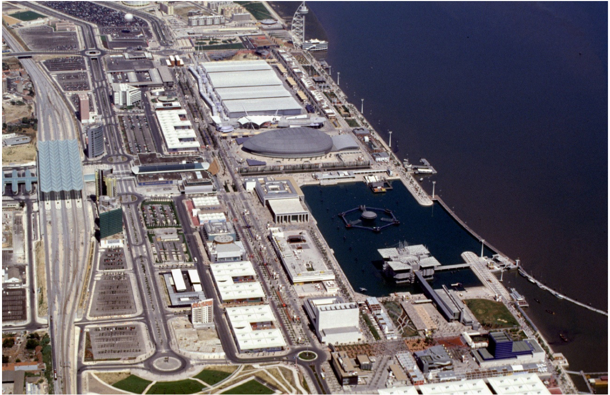
Figura 7 Frente renovado del Tajo en Lisboa (1998)
