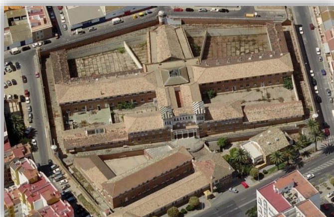
Imagen III: Probablemente la “segunda fachada” de la Prisión Provincial de Huelva. 156 Imagen IV: Fotografía área de la Prisión Provincial de Huelva. 157
