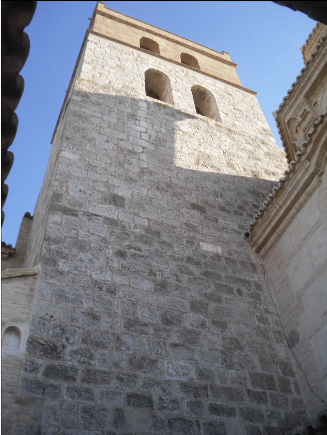
Imagen 2. Una de las torres de Magallón que aún se conservan.
