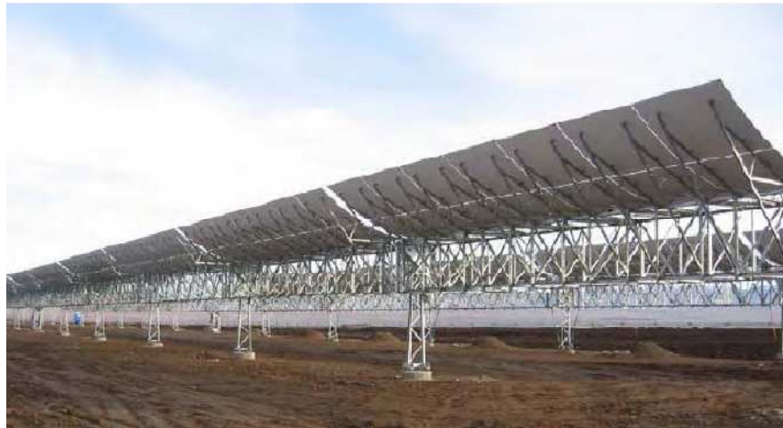
Figura 10: Estructura SKAL-ET instalada en la planta Andasol-1
