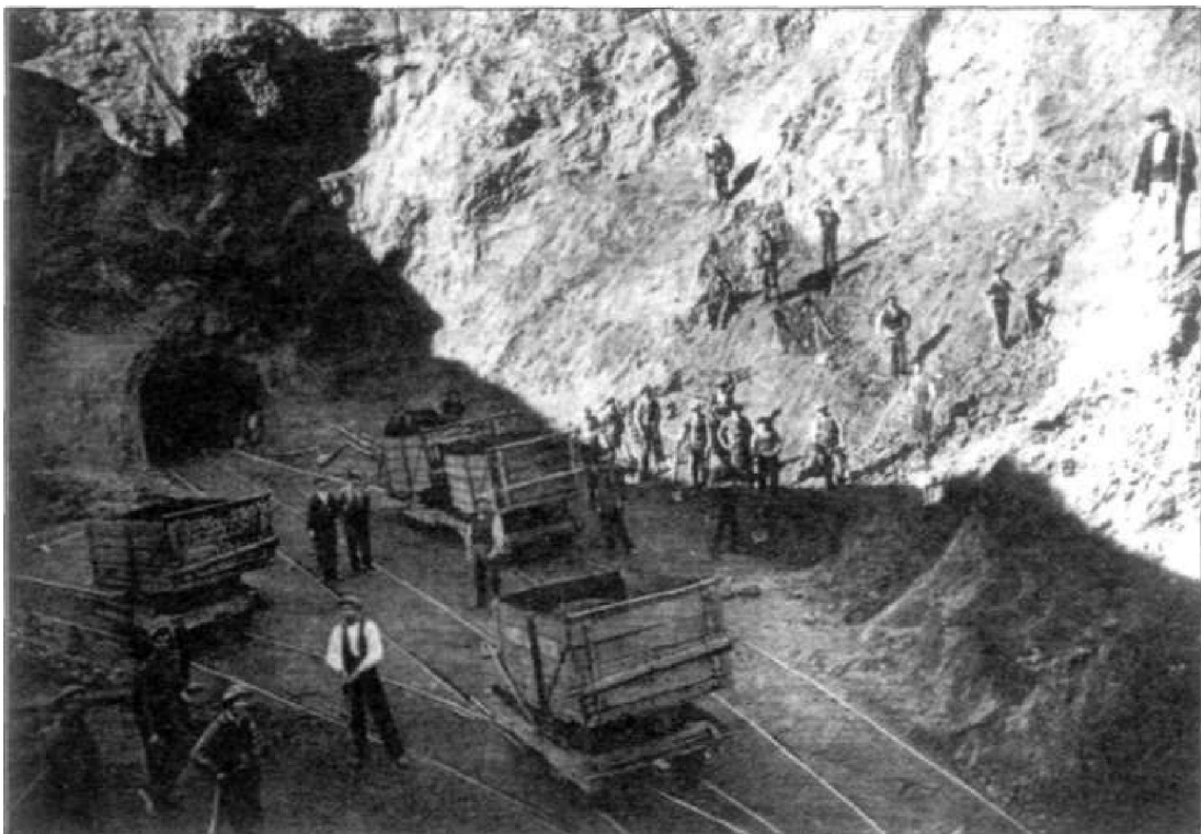
Figura 4. Se puede observar en primer plano vagones sobre "vía muerta" para el transporte del mineral al ferrocarril minero.
