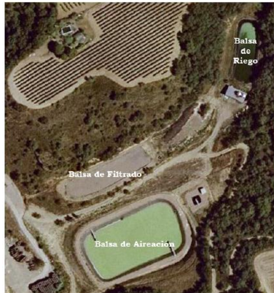
Figura 3.2: Balsa de riego y EDAR.
