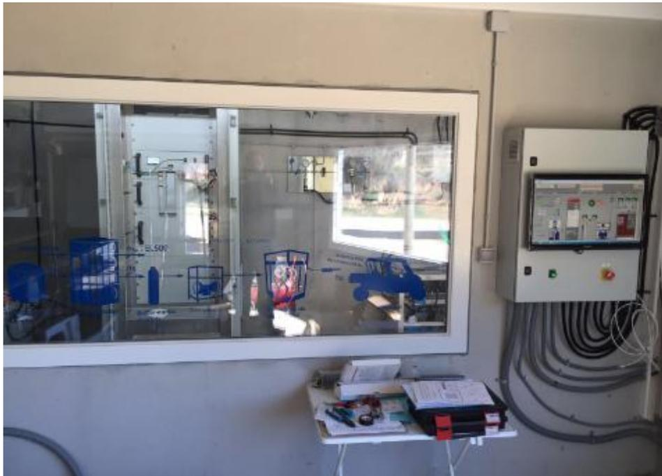
Figura 3.21: Pantalla táctil para el control de la instalación.
