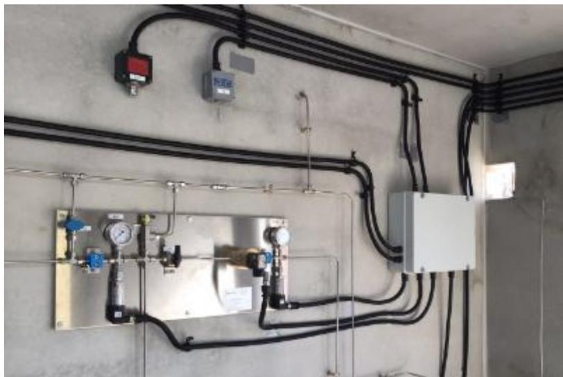
*Figura 3.14: Panel de distribución de hidrógeno.*
