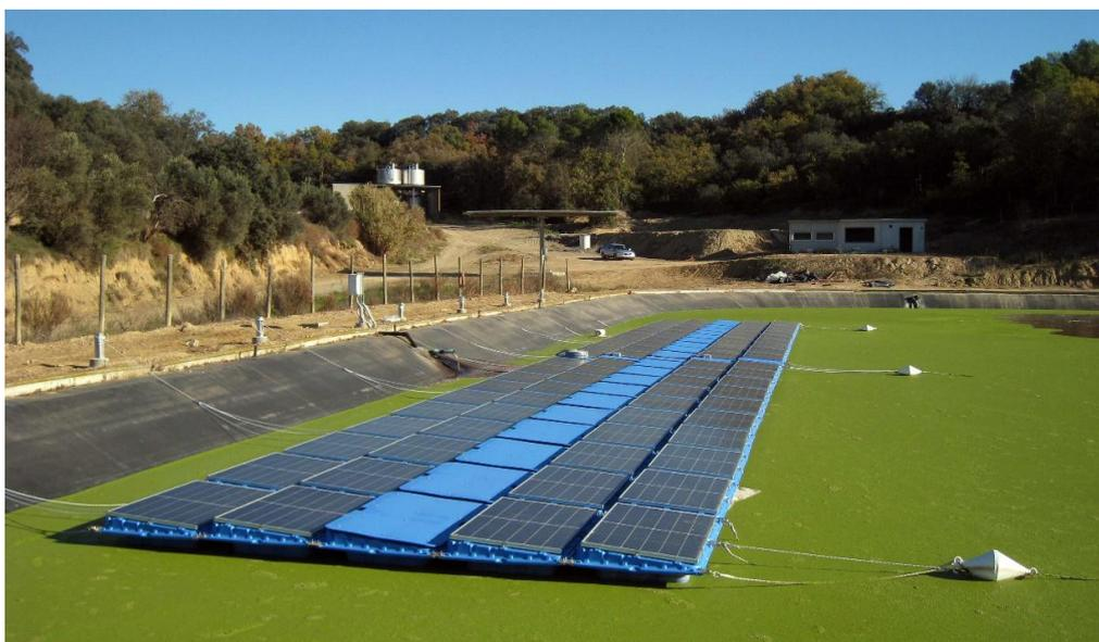
*Figura 3.6: Sistema de paneles fotovoltaicos flotantes.*
