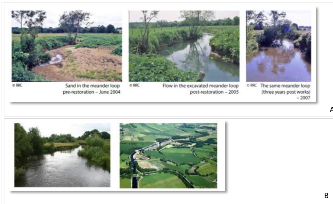
Figura 48.- Ejemplos de reconexión de meandros. (A): río Rothen (Petworth). Fuente: The River Restoration Center . (B): río Regge. Foto: Piet Verdonschot 39 .
