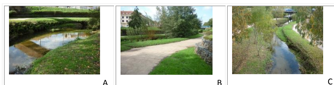
Figura 38.- Alteraciones detectadas en los tramos de estudio del ayuntamiento de Ames.
