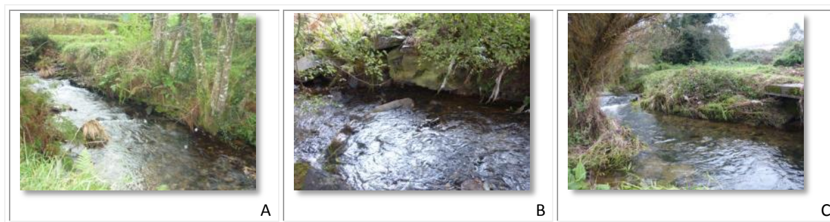
Figura 51.- Zonas con protecciones de escollera en las márgenes que podrían ser eliminadas. (A): tramo Sarela_Sector1; (B): Sar_SC_Sector1; (C): Sar_SC_Sector2.
