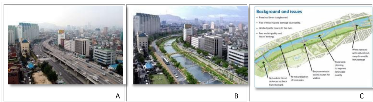
Figura 7.- Ejemplos de rehabilitación fluvial de tramos urbanos. Río Cheonggyecheon antes (A) y después (B) del proyecto de recuperación fluvial. Fuente: Landscape Architecture Foundation . (C): proyecto de restauración del río Isar en Munich. Fuente: Restore Project (2013).
