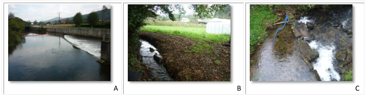
Figura 24.- Ejemplos de las derivaciones de caudal observadas en los tramos de estudio.
